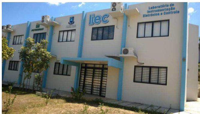
Figura 01: Fachada do edifício Gurdip Singh Deep na UFCG, sede do LIEC.
