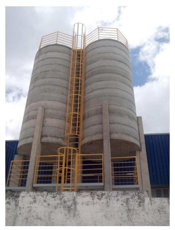
Figura 30 - Caixa d'água com ausência de um SPDA.
