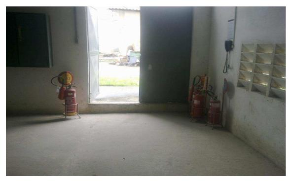
Figura 18 –Extintores da Subestação de 69 kV.
