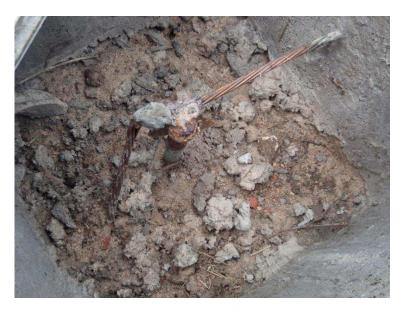
Figura 25 – Solda exotérmica haste/cabo.
