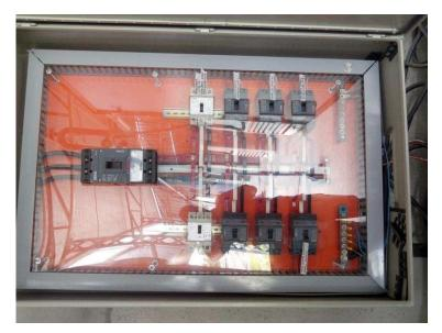
Figura 26 -Painel aterrado com uma malha individual.
