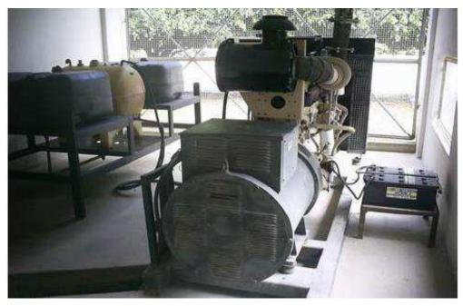
Figura 16 – Gerador de 450kVA.
