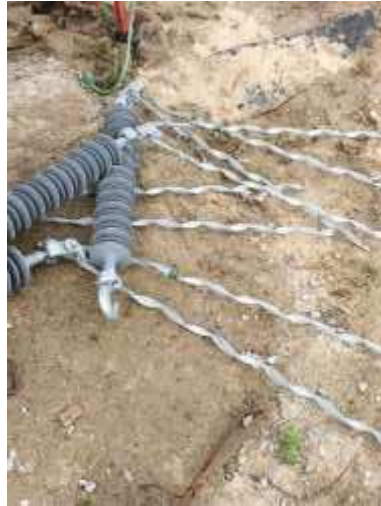
Figura 4.10: Isolador de suspensão com alça pré-formada para comportar o cabo.
