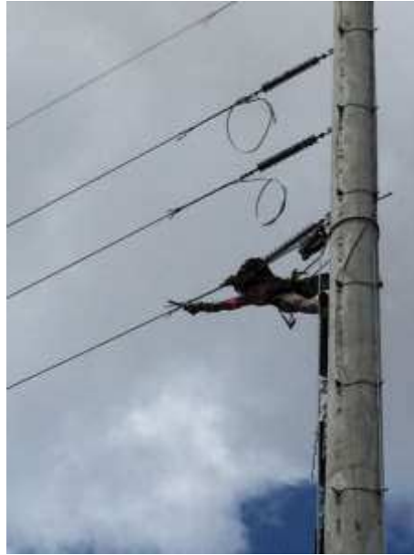
Figura 4.13: Encabeçamento de cabo na alça pré-formada.
