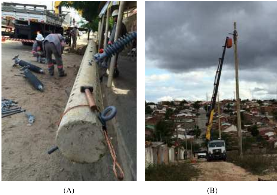
Figura 4.8: Montagem de estruturas: (A) antes da implantação do poste; (B) com o poste já implantado.
