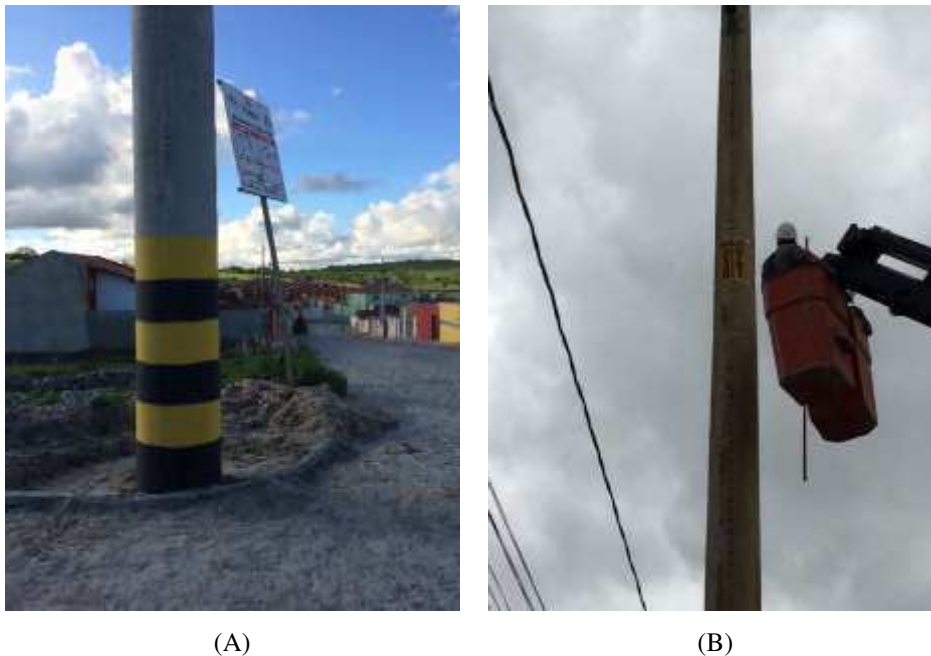
Figura 4.17: Finalização de estruturas: (A) pintura de sinalização; (B) placas de identificação.
