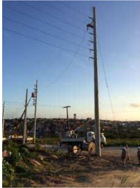
Figura 4.11: Lançamento de cabos.
