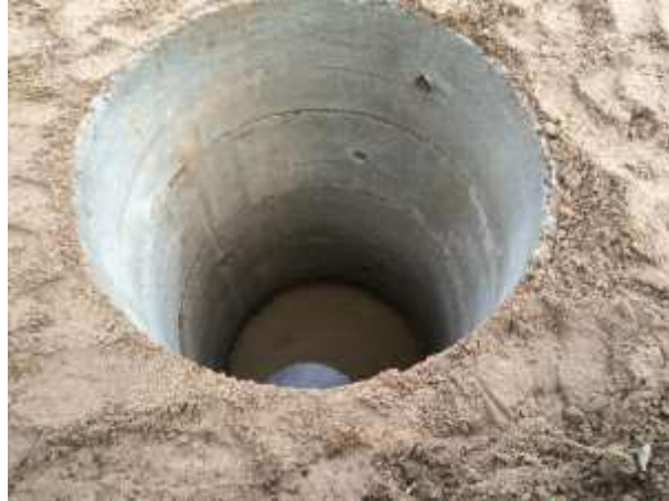
Figura 4.4: Cava com manilhas de concreto.
