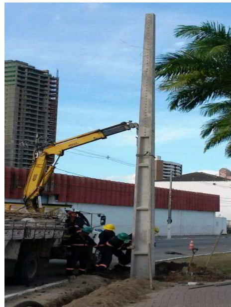
Figura 17: Alocação do poste da subestação.
