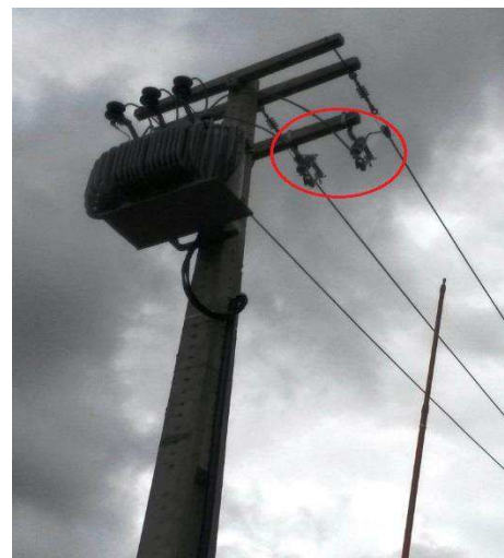
Figura 19: Fechamento das chaves fusíveis do transformador.
