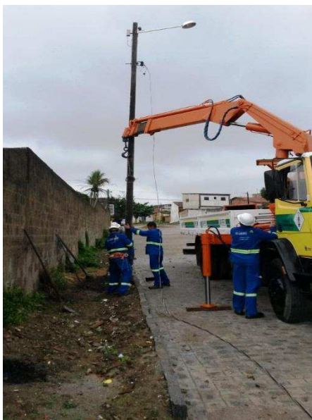
Figura 28: Poste sendo alocado.
