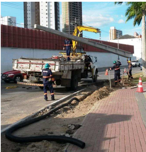
Figura 17: Alocação do poste da subestação.
