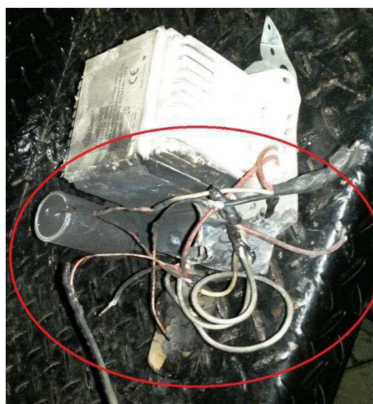
Figura 23: Cabos e reatores internos em péssimas condições.
