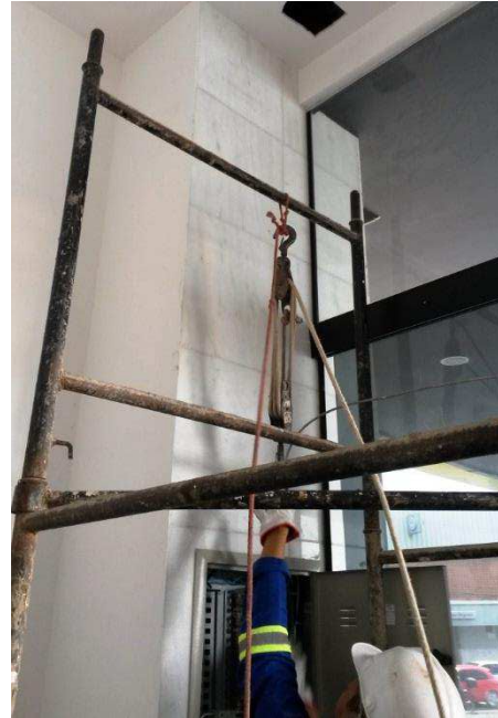
Figura 18: Passagem dos cabos da subestação para o quadro geral.
