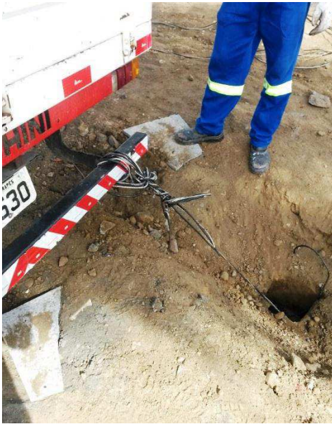
Figura 18: Passagem dos cabos da subestação para o quadro geral.
