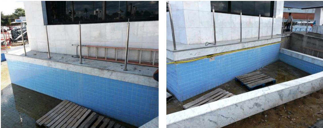
Figura 12: Passagem de eletroduto e cabo PP pela parede.
