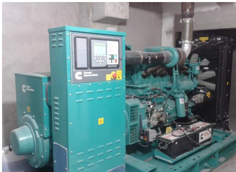
Figura 11–gerador 500 kVA.
