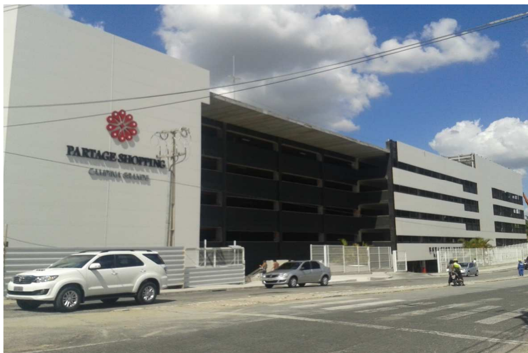
Figura 1–Fachada deck parking Shopping Partage, fase de construção.
