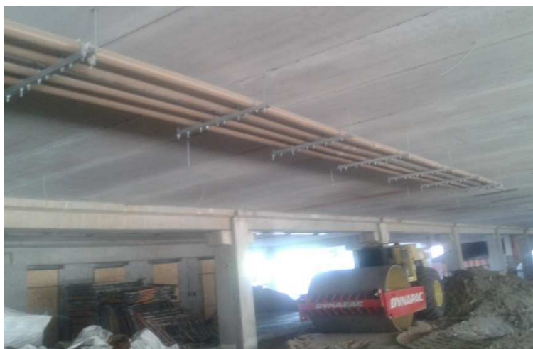
Figura 20—barrilete de água.
