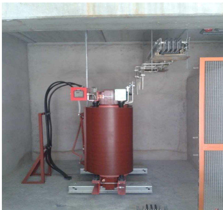
Figura 8–Transformador 1000 kVA.
