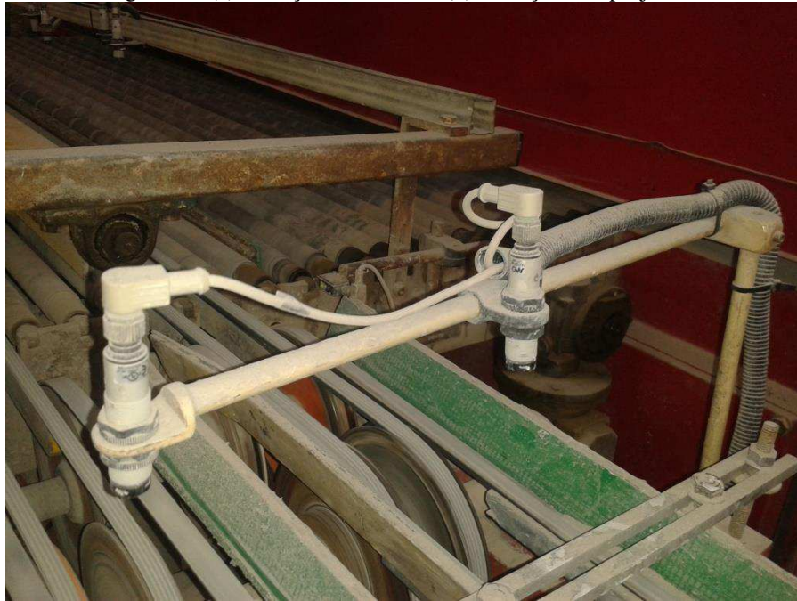
Figura 15. (a) Proteção inexistente; (b) Proteção mal projetada.
