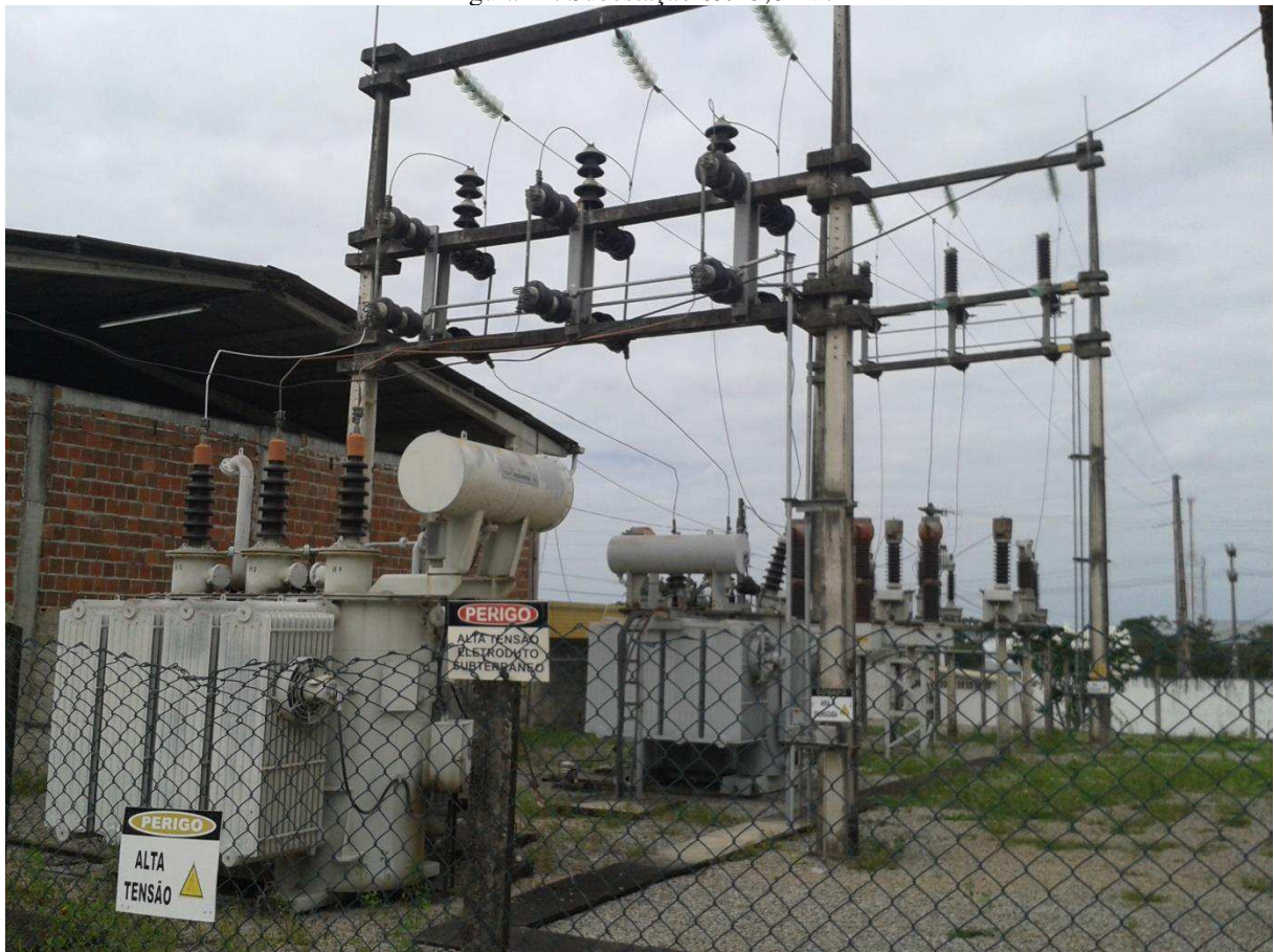
Figura 12. Subestação 69/13,8 kV.
