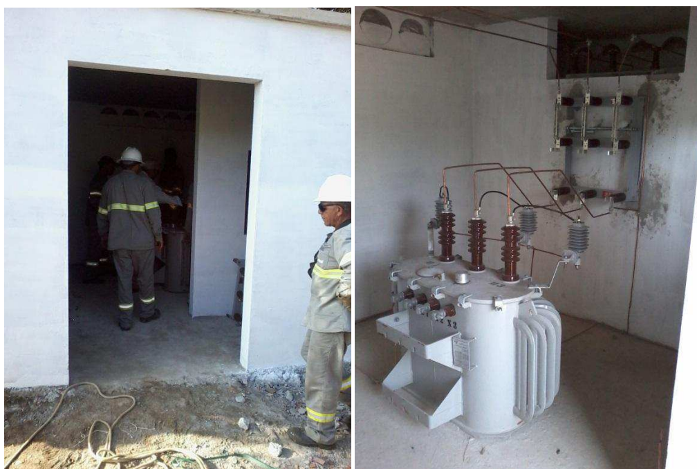
FIGURA 3 ELETRICISTAS INSTALANDO TRANSFORMADOR DE 150 kVA NA SUBESTAÇÃO DO LOTEAMENTO
