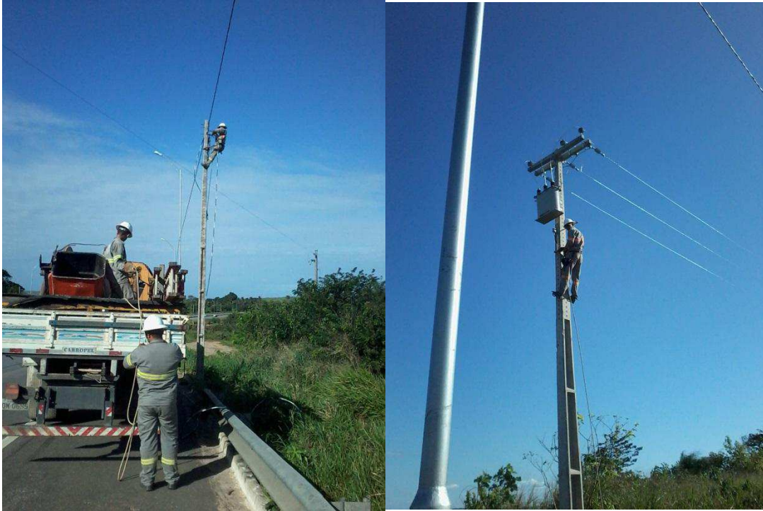
FIGURA 4 ELETRICISTAS INSTALANDO A I.P. DA BR 101 - CONTRATO COM O DNIT
