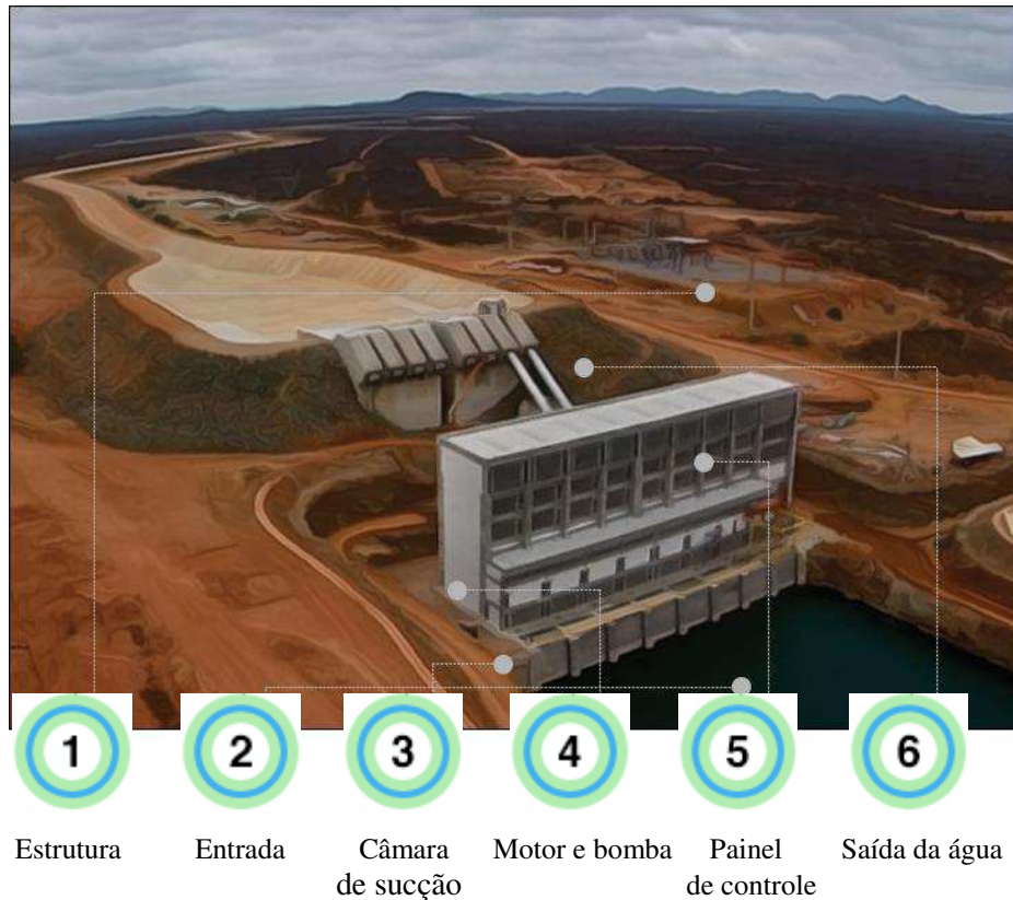
FIGURA 5 FUNCIONAMENTO DE UMA ESTAÇÃO DE BOMBEAMENTO DA TRANSPOSIÇÃO DE ÁGUAS DO RIO SÃO FRANCISCO
