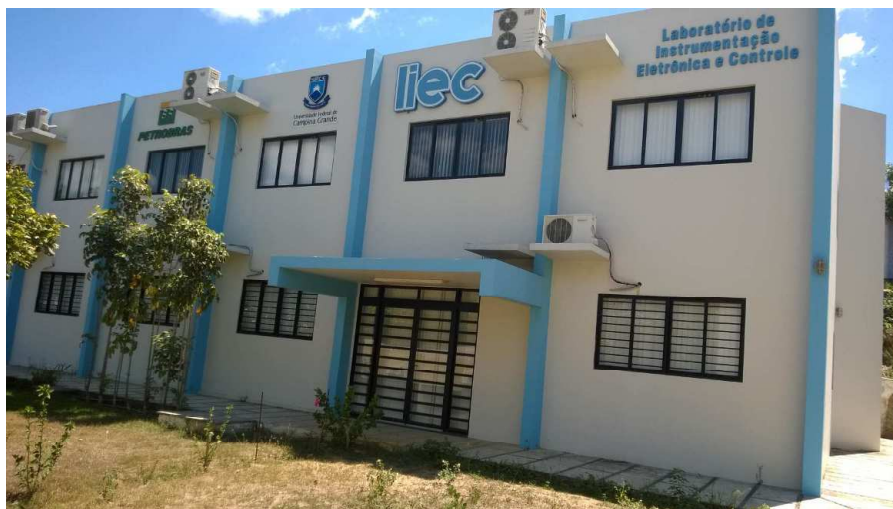
Figura 1 – Fachada do LIEC.
