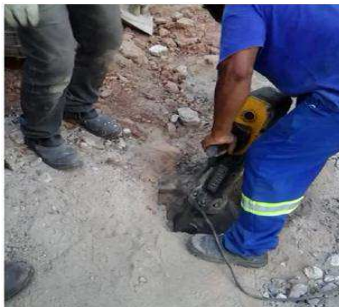
Figura 3.7- Escavação dos buracos para alocação dos postes
