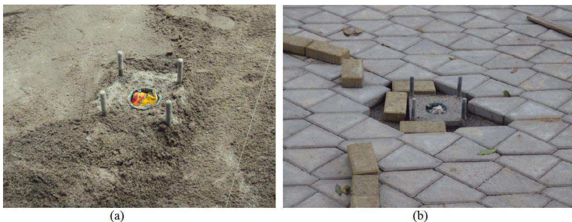
Figura 3.8 - (a) Base do poste chumbada, e seu nivelamento em relação ao bloco intertravado
