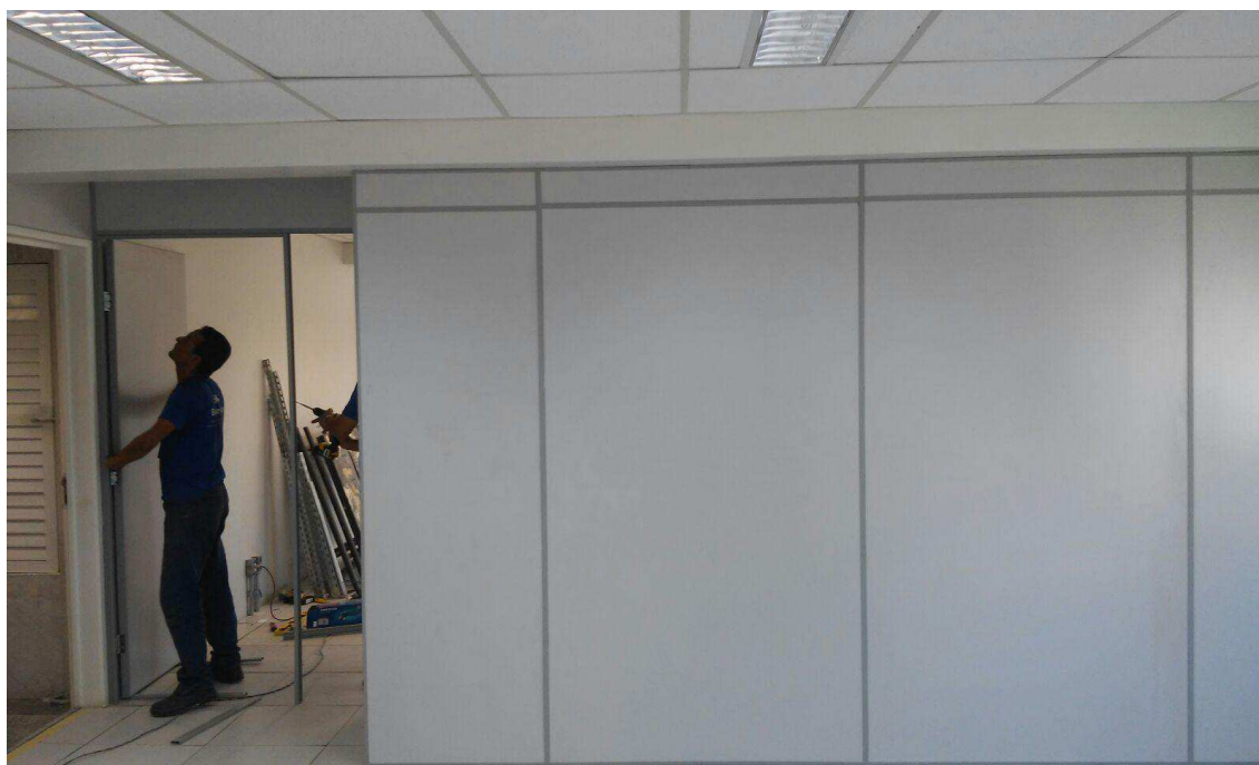
FIGURA 14. DIVISÓRIAS SENDO FIXADAS
