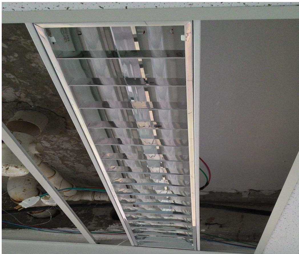
FIGURA 10. INSTALAÇÃO DAS LUMINÁRIAS
