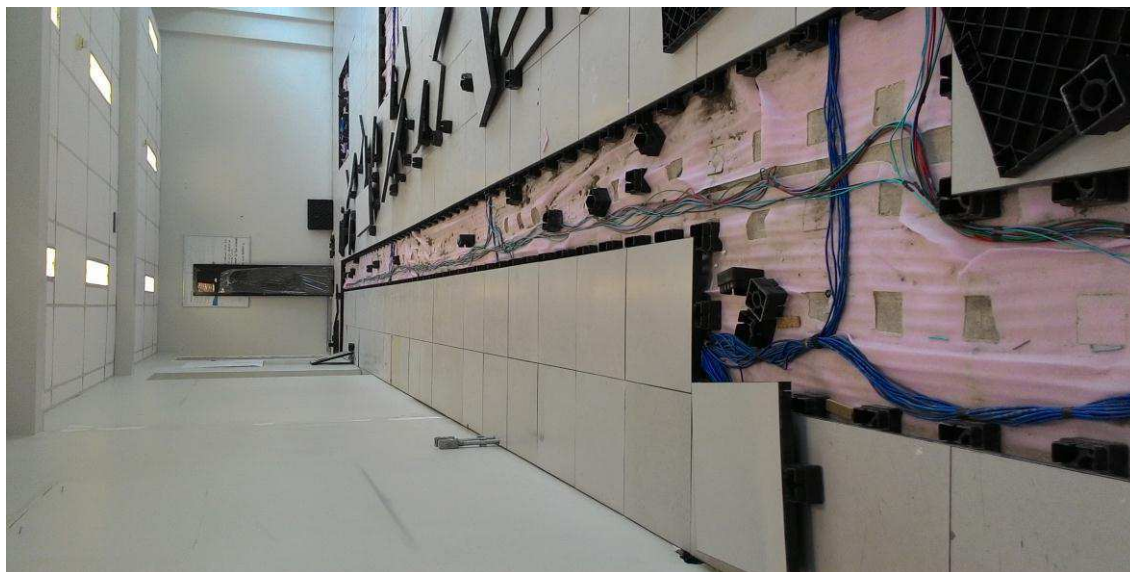
FIGURA 5. LANÇAMENTO DE CABOS DE ENERGIA E REDE PELO PAVIMENTO
