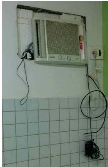
Figura 1: Instalação de ar condicionado.
