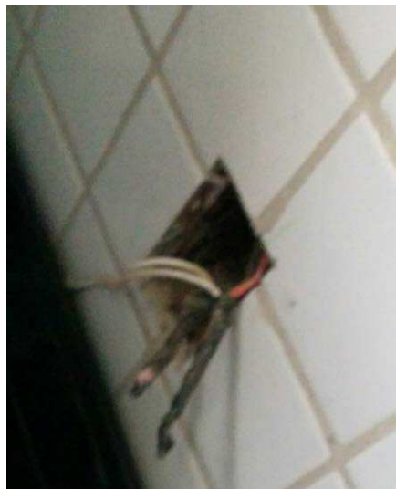
Figura 2: Fiação exposta.
