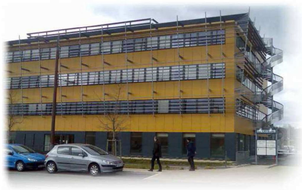
Figura 1 – Edifício da NetCeler localizado em Valence
