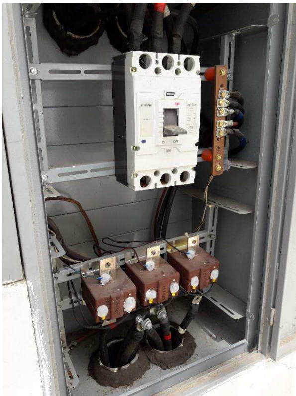
Figura 3 – Remoção de TC de um quadro de medição.
