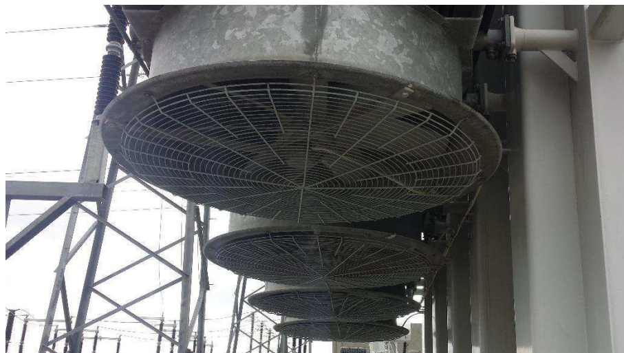
Figura 11 - Grades dos ventiladores restauradas.
