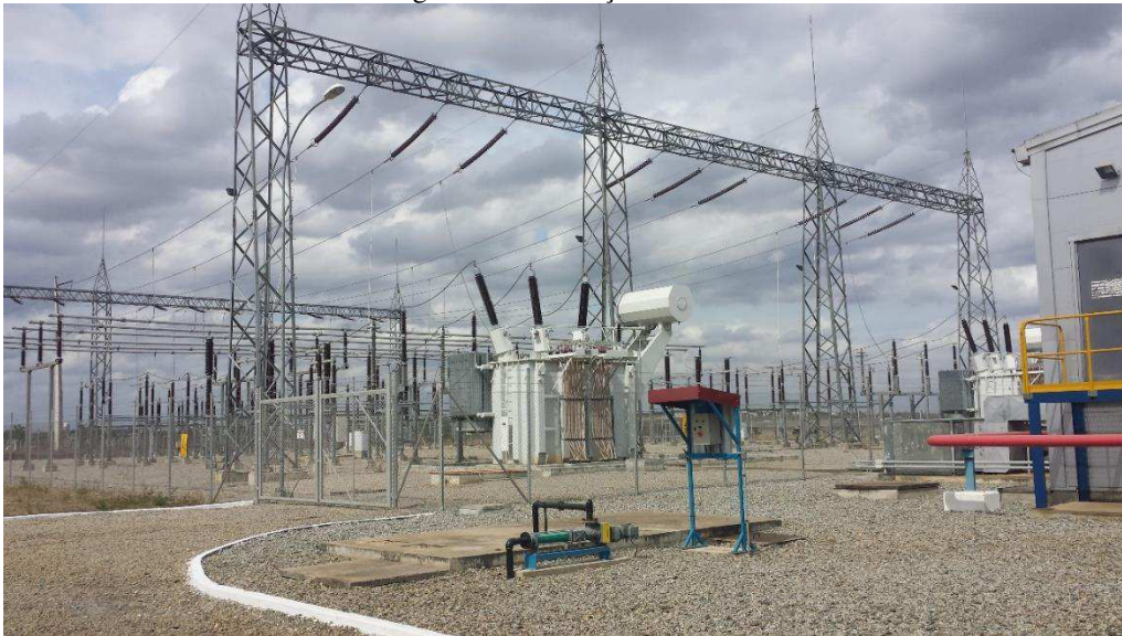
Figura 7 - Subestação 230 kV.
