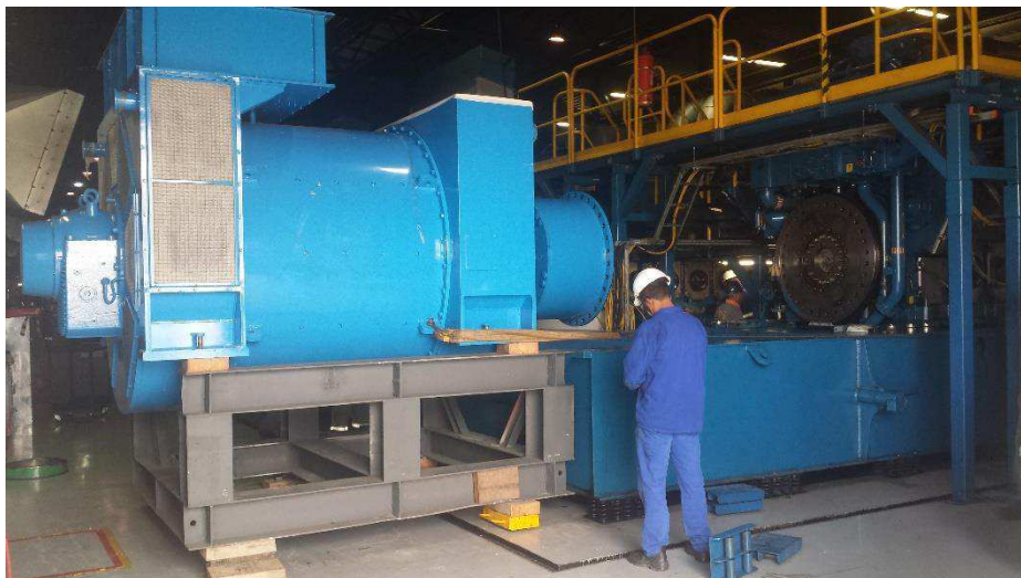
Figura 13 - Gerador AVK sendo reacoplado ao motor.
