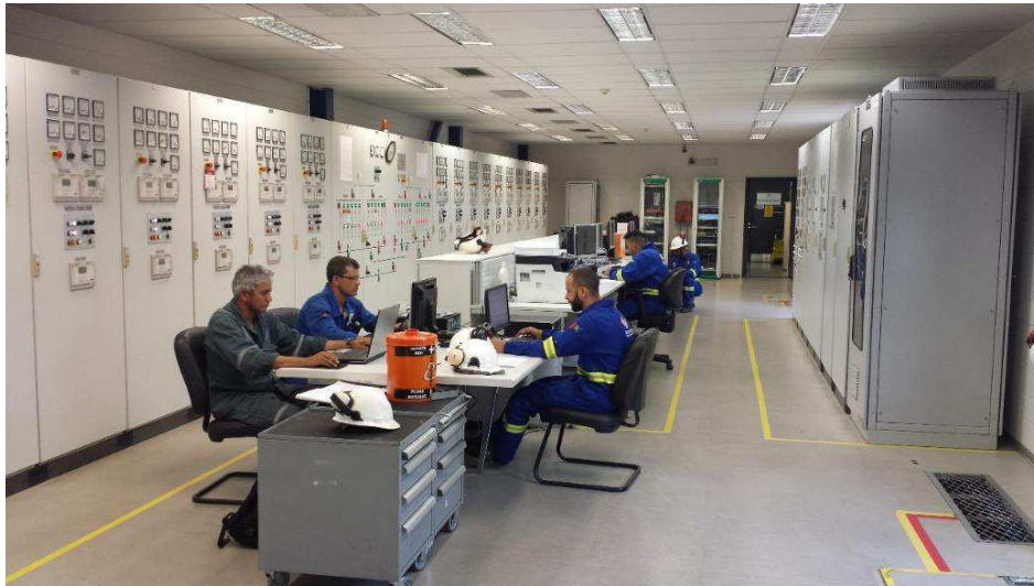
Figura 5 - Sala de controle.
