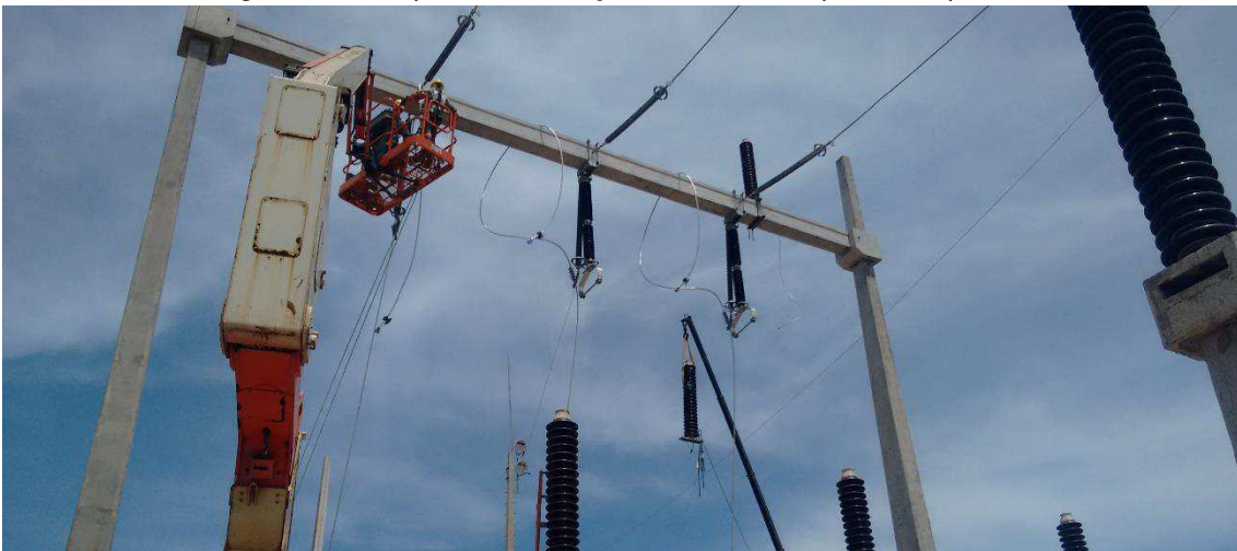
Figura 44 – Etapas da instalação do desvio no pórtico superior.
