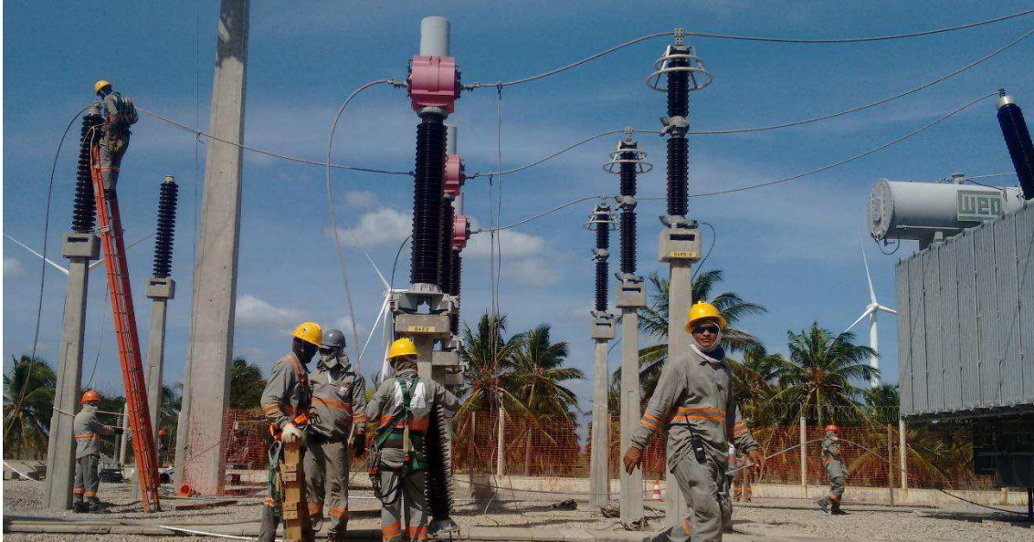
Figura 43 – Desmontagem do barramento existente.
