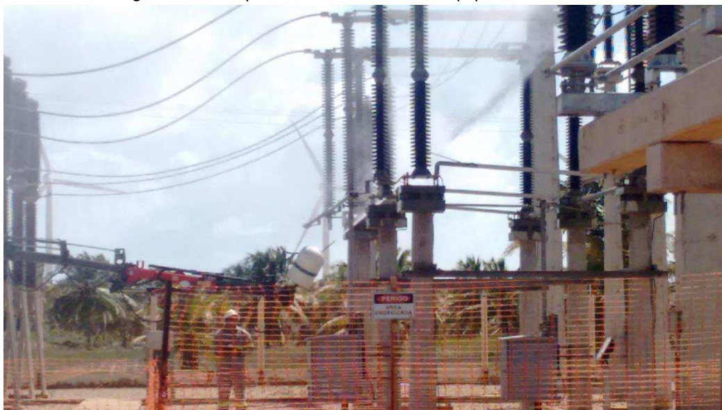
Figura 46 – Limpeza dos invólucros de equipamentos da SE.
