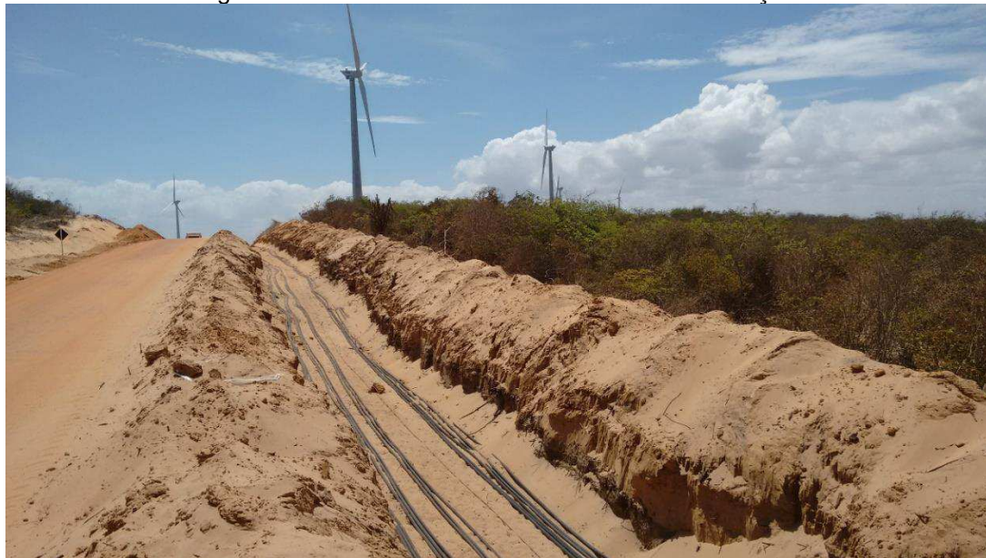
Figura 29 – Trecho da RMT subterrânea em construção.
