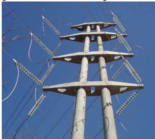
Figura 7 – Estrutura de ancoragem de concreto.
