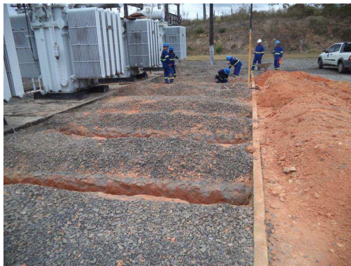
Figura 2.21 – Escavações no setor de 13,8 kV.
