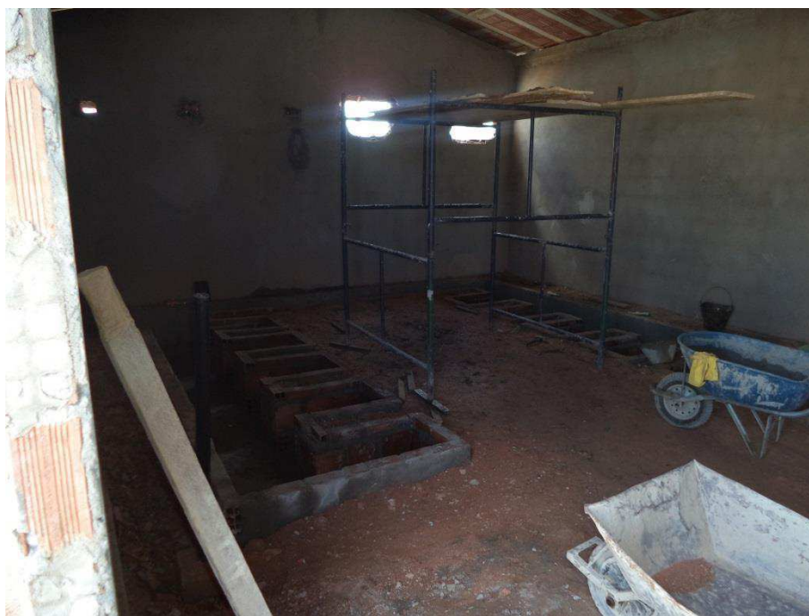
Figura 2.5 – Construção casa de comando na SE São Benedito.
