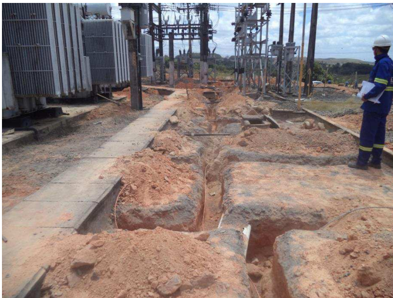
Figura 2.25 – Lançamento de cabos para formação de novo reticulado.
