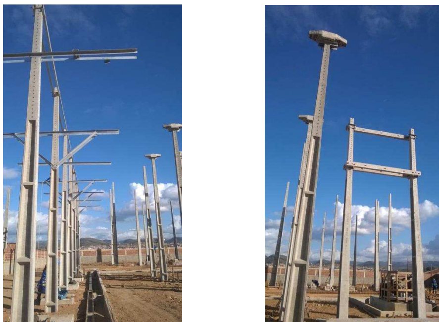
Figura 2.8 – Instalação estruturas de concreto setor de 13,8 e 69 kV.
