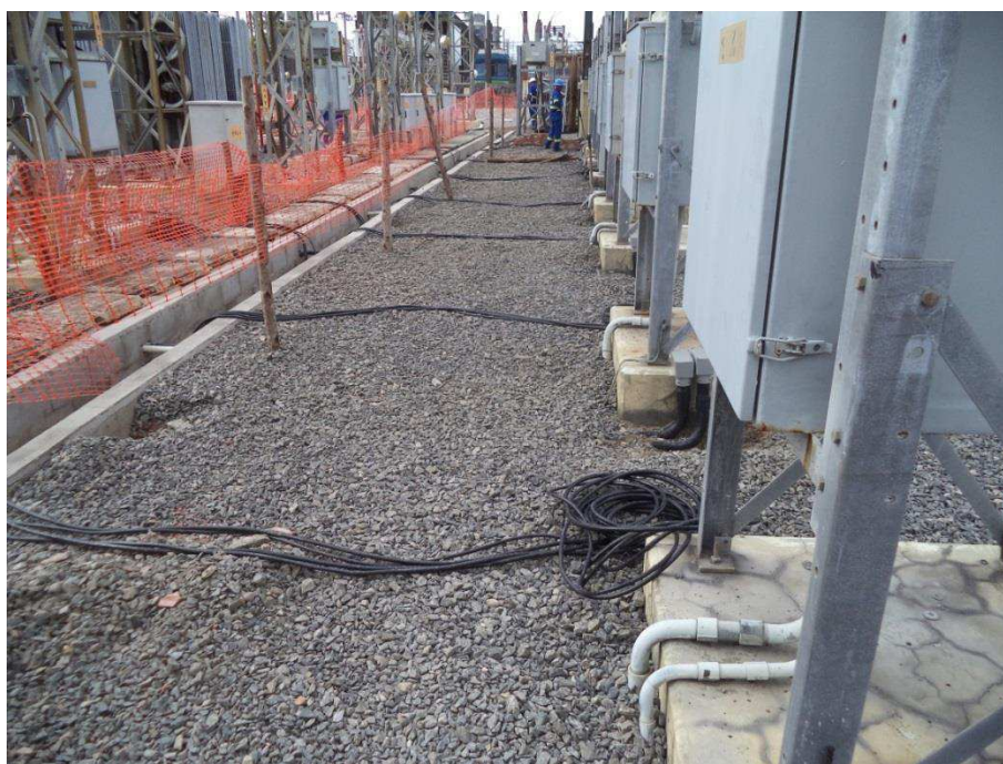
Figura 2.3 – Lançamento de cabo dos religadores na SE Gasometro.
