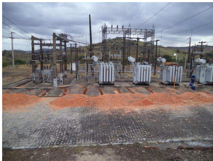
Figura 2.22 – Escavação setor 13,8 kV.
