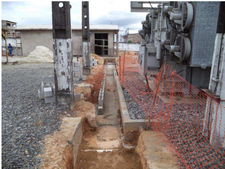
Figura 2.4 – Construção da casa de comando e escavação da nova canaleta SE Ibura.
