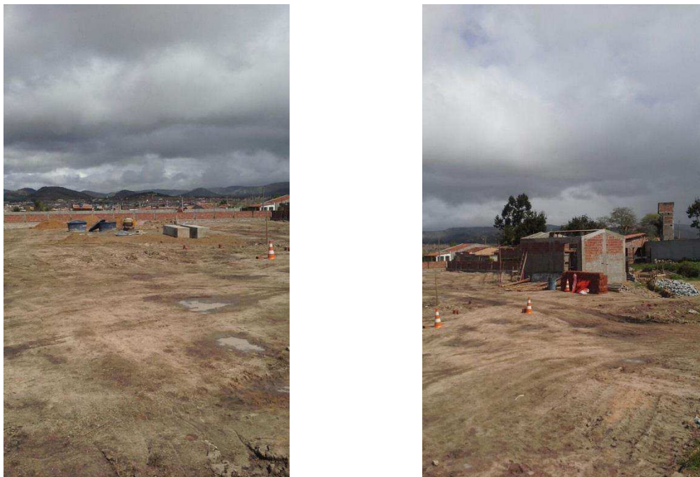
Figura 2.7 – Construção da base do transformador, casa de comando e muro divisório.
