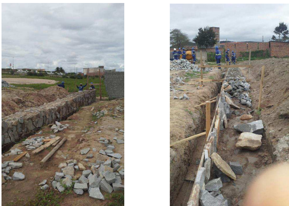
Figura 2.6 – Construção do muro de arrimo.
