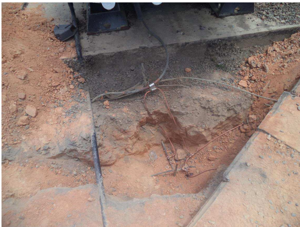
Figura 2.27 – Conexão do neutro do transformador com a nova malha de aterramento.
