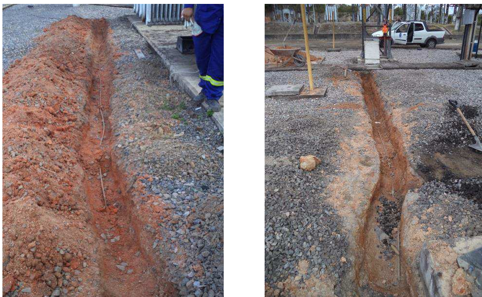
Figura 2.11 – Escavação nos setores 13.8 e 69 kV.
