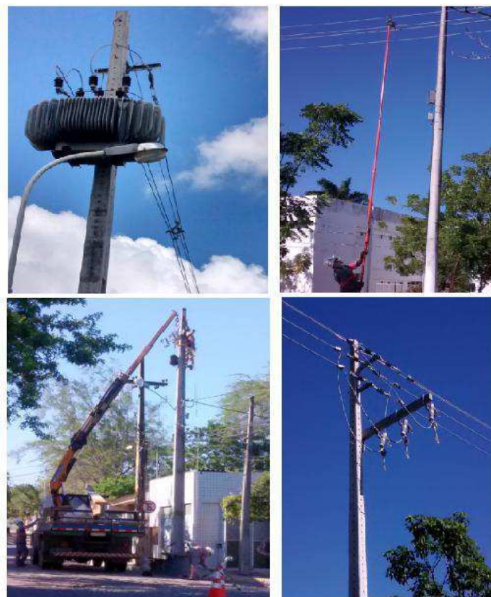
Figura 14 - Montagem da Rede de Distribuição
