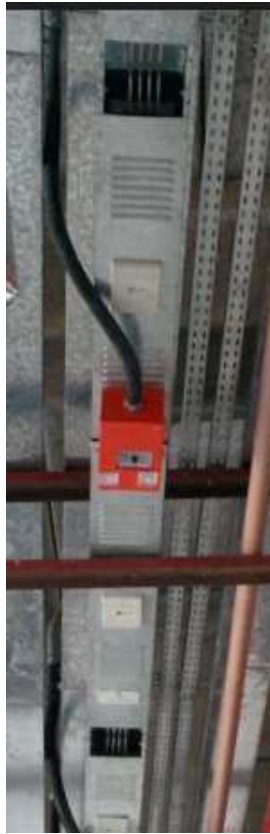
Figura 13 - Plug-in de alimentação instalado no Busway
