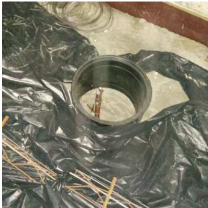
Figura 16 - Instalação de uma das caixas de inspeção do SPDA
