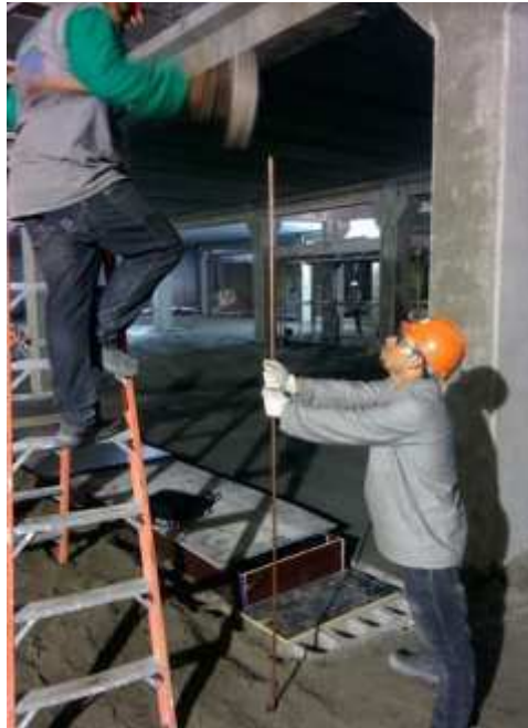
Figura 16 - Instalação de uma das caixas de inspeção do SPDA
