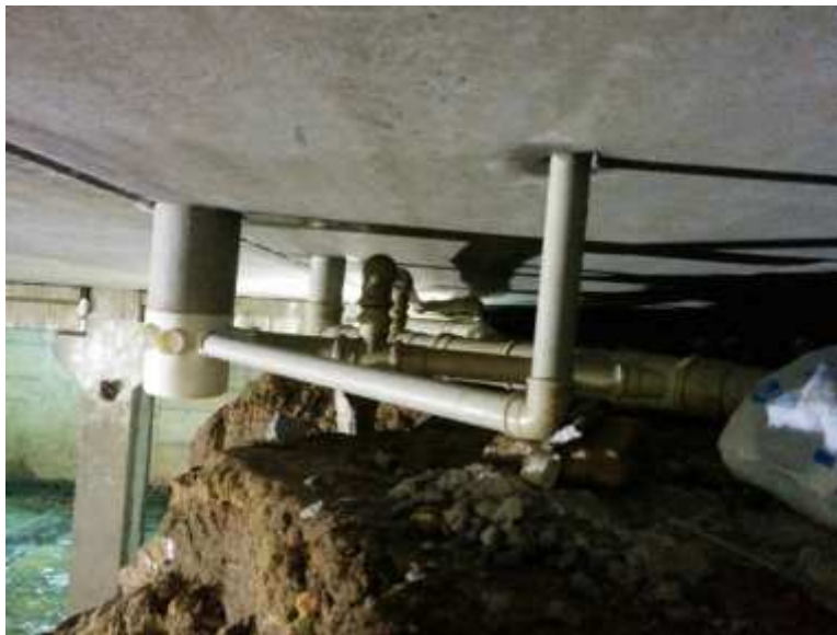
Figura 8 - Acompanhamento das instalações hidrosanitárias referente ao sanitário do térreo F3
