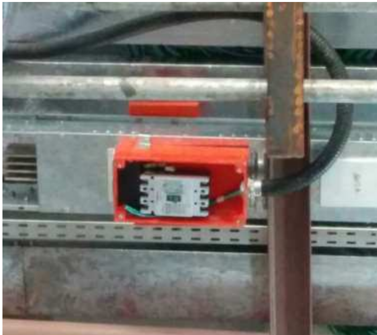
Figura 13 - Plug-in de alimentação instalado no Busway
