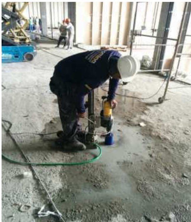
Figura 11 - Acompanhamento do terceirizado responsável pela realização de furos.
