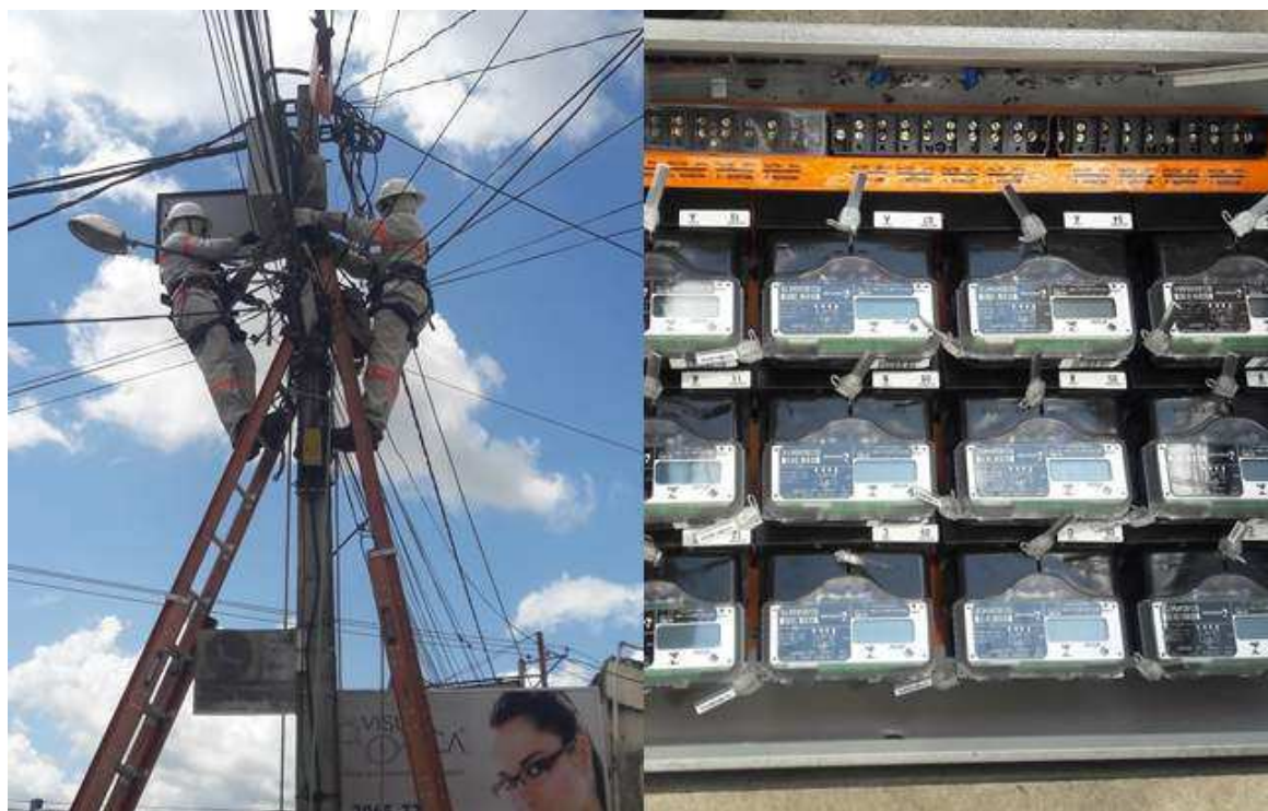
Figura 28 – Instalação do sistema Garnet na Rodoviária Velha.
