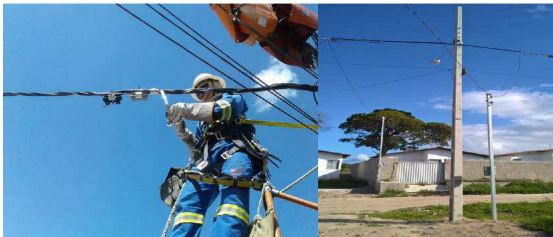
Figura 9 – Blindagem de Circuito.
