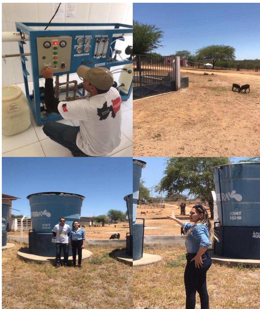
IMAGEM 5: Estrutura física do sistema de dessalinização de água da Unidade Demonstrativa de Amparo/PB.
