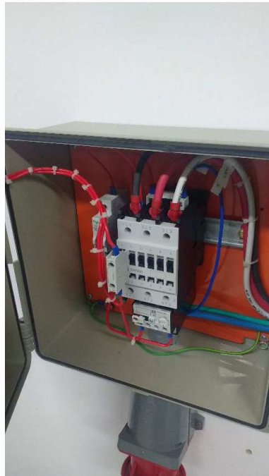
Figura 15 – Detalhe interno da caixa de comando do Plug
