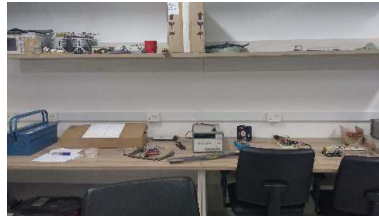
Figura 17 – Tomadas elétricas e de rede acima da bancada
