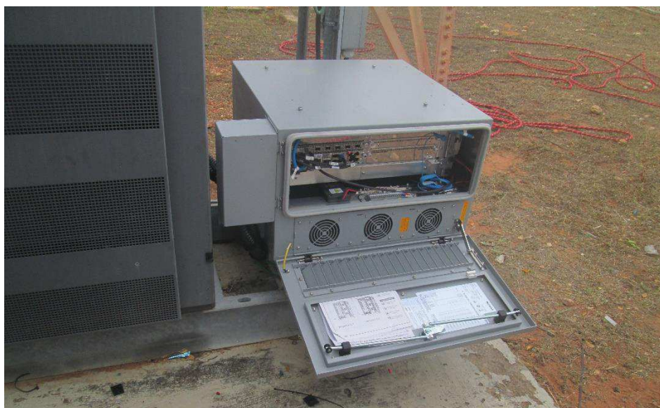
Figura 17 - Gabinete FCOB com System Module instalado no site NLJNJN00, Jaguaribara/CE (Fonte: SAVENGE Engenharia LTDA)
