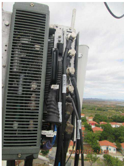
Figura 16 - Módulo de RF instalado no site NLNRNR01, Jaguaribara/CE (Fonte: SAVENGE Engenharia LTDA)
