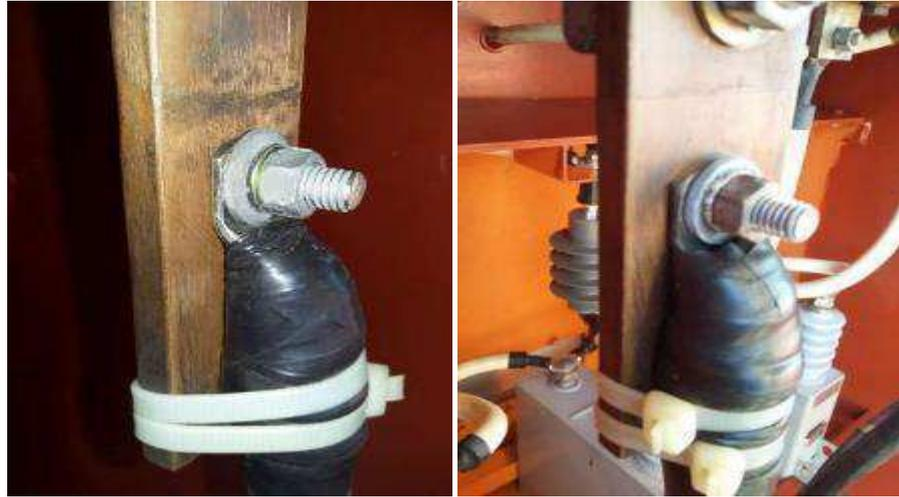
Figura 53: Terminal utilizado com pouca área de contato
