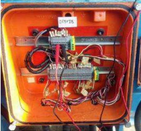
Figura 47: Caixa de ligação sensores de vibração
