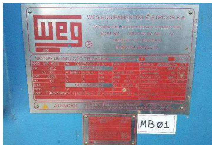
Figura 34: Placa de dados do motor
