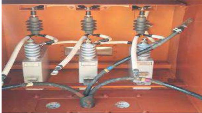
Figura 52: Capacitores para correção do fator de potência
