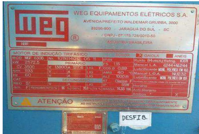
Figura 44: Placa de dados do motor
