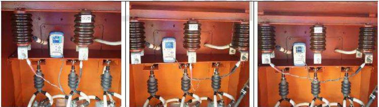
Figura 51: Medição nas fases U-V, V-W e W-U do estator
