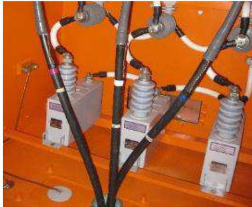
Figura 42: Capacitores para correção do fator de potência
