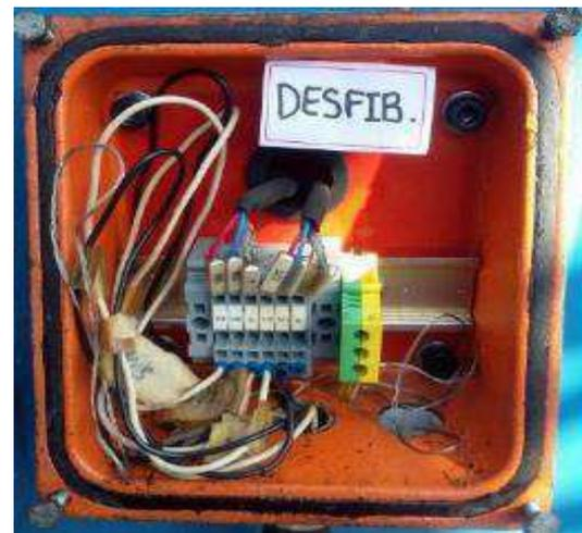
Figura 46: Caixa de ligação resistência de aquecimento
