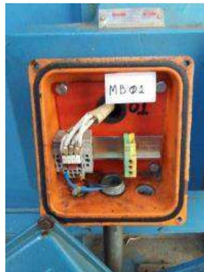
Figura 37: Caixa de ligação resistência aquecimento
