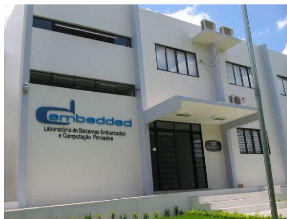
Figura 2-1: Fotografia da estrutura externa do embedded.
