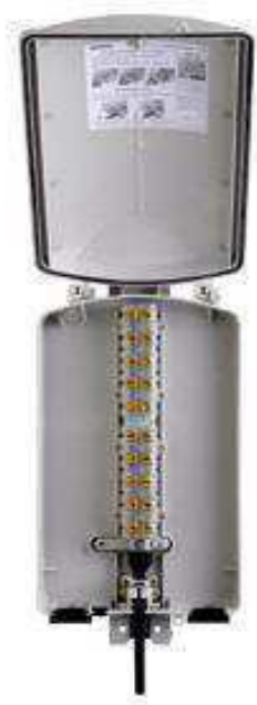
Figura 3-3: Fotografia do Terminal de Acesso da Rede de 20 PARES – TM
