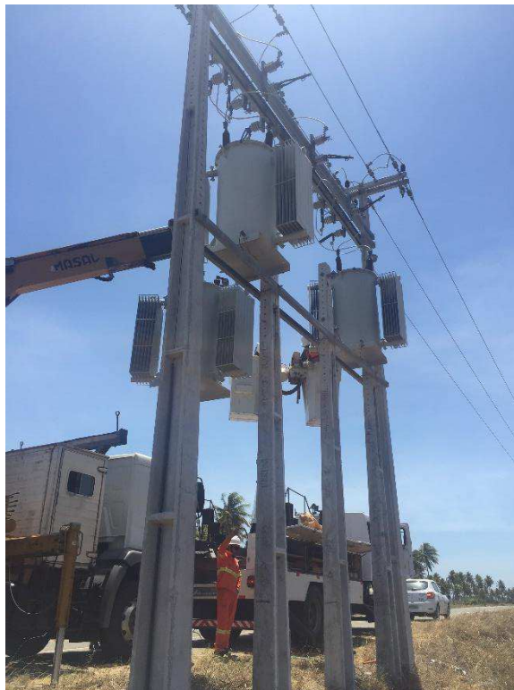
Figura 18: Manutenção em um regulador de tensão
