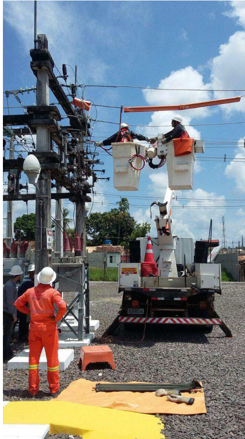
Figura 15: Manutenção em linha viva
