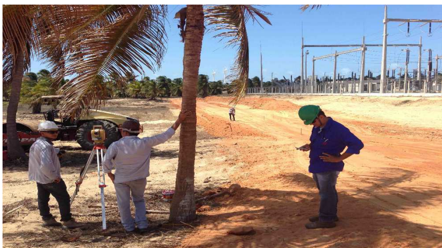
Figura 14 – Locação topográfica para aterramento
