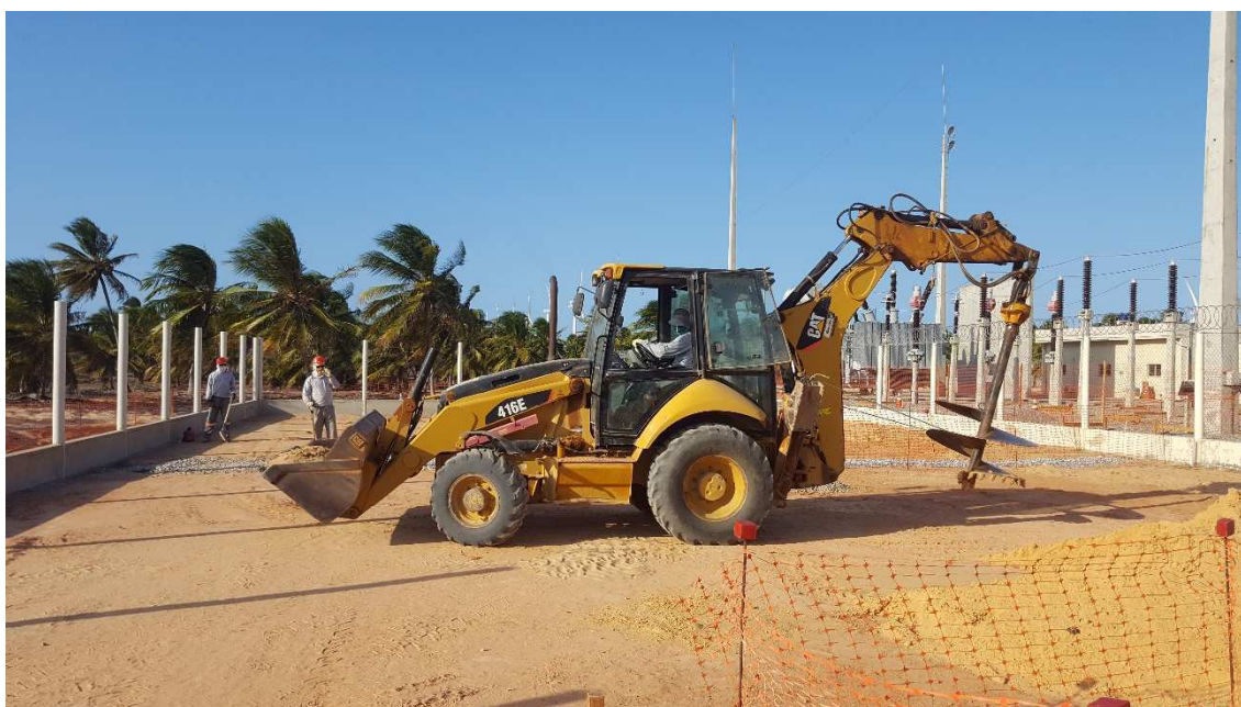
Figura 21: Escavação das fundações
