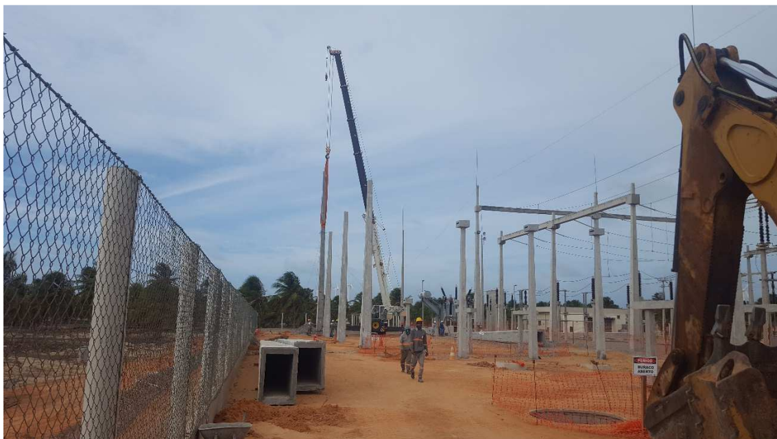
Figura 23: Instalação de Pórtico com uso de Guindaste
