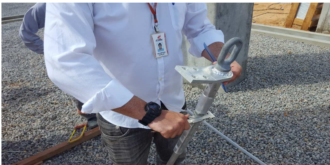
Figura 30: Cabo prensado com conector
