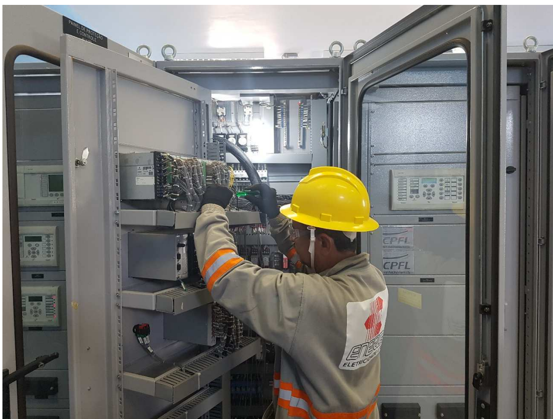
Figura 33: Lançamento de cabos para painel da Sala de comando – SE ICZ
