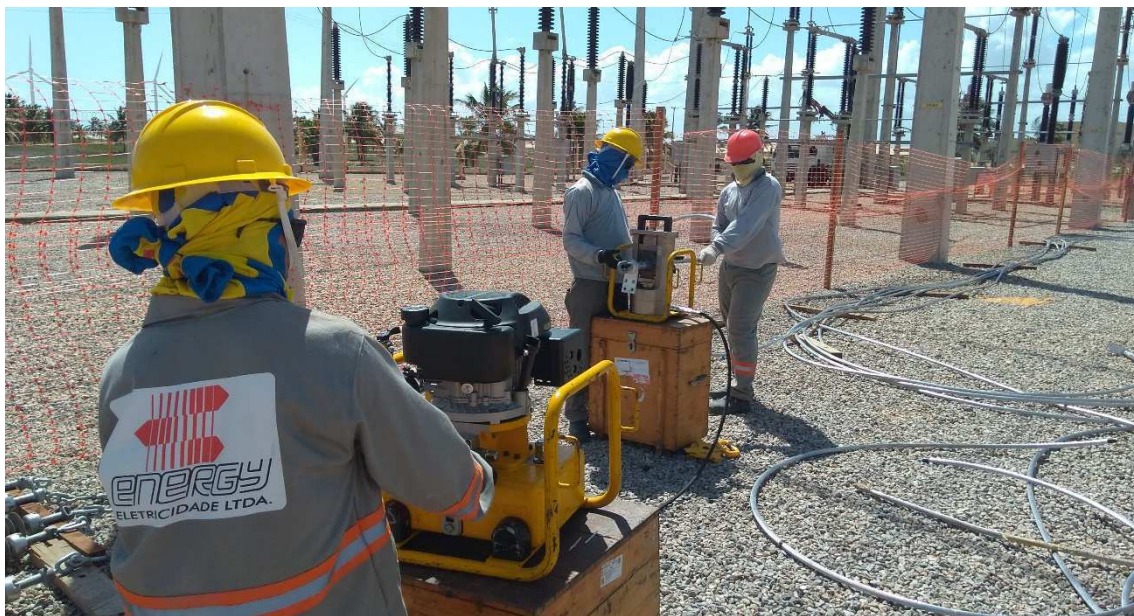
Figura 29: Prensamento de Cabos
