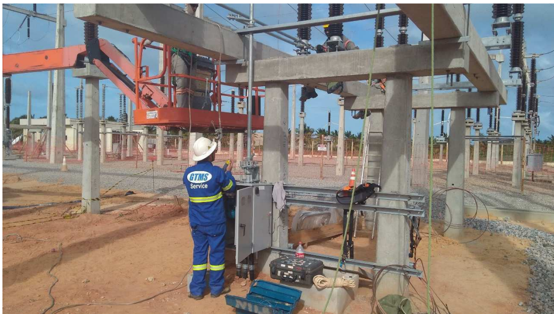
Figura 26: Comissionamento de Chaves Seccionadoras
