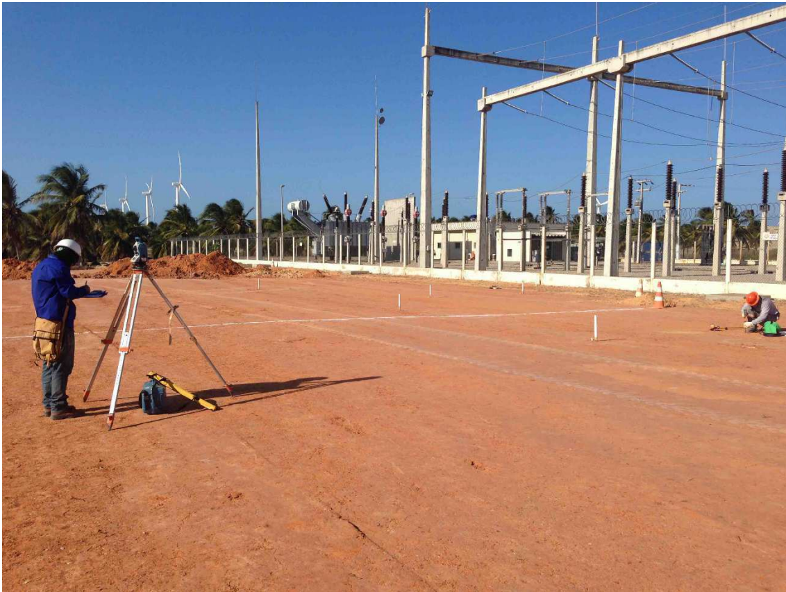
Figura 18: Locação Topográfica dos Pontos da SE.
