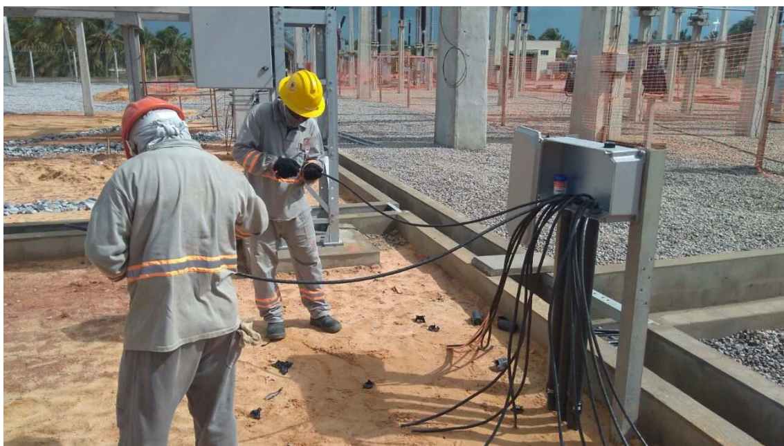
Figura 32: Passagem de Cabos para Caixa de Comando
