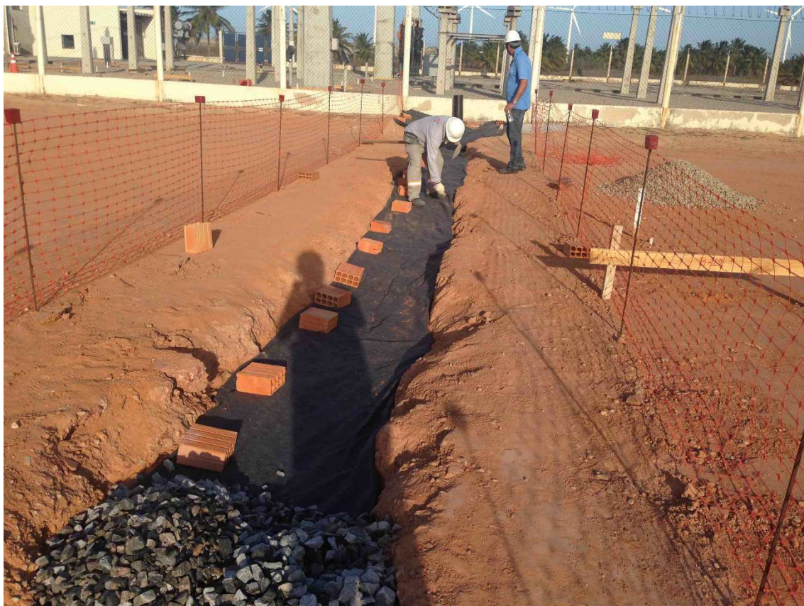
Figura 20: Instalação do Sistema de Drenagem
