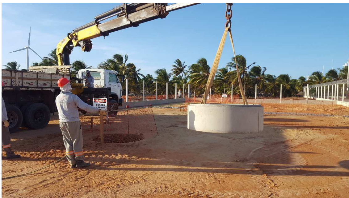
Figura 22: Instalação de Manilhas
