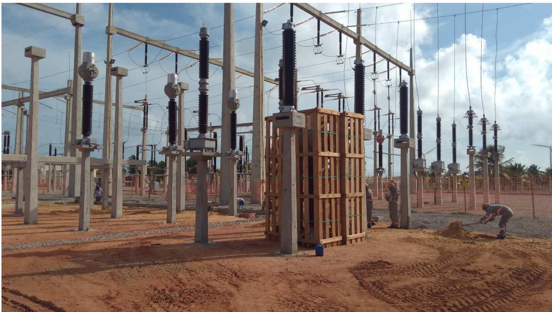
Figura 25: Etapa de Instalação de Equipamentos
