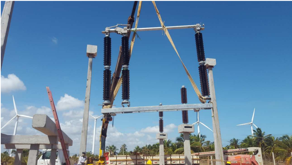
Figura 24: Instalação de Chaves Seccionadoras
