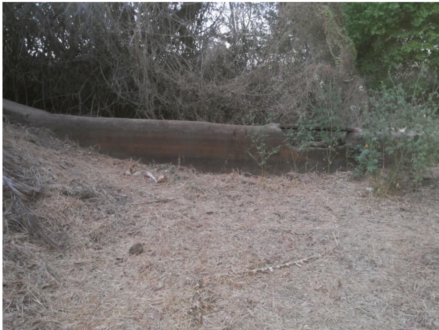
Foto 10 – Barramento de alvenaria
