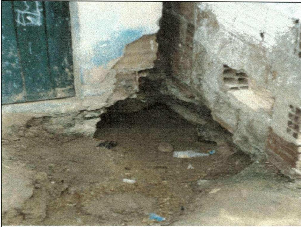
Figura 13. Processo erosivo comprometendo a estrutura da residência
