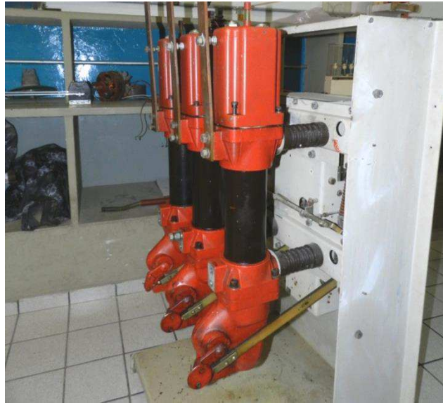
Figura 4.1: Fotografia do disjuntor Siemens.
