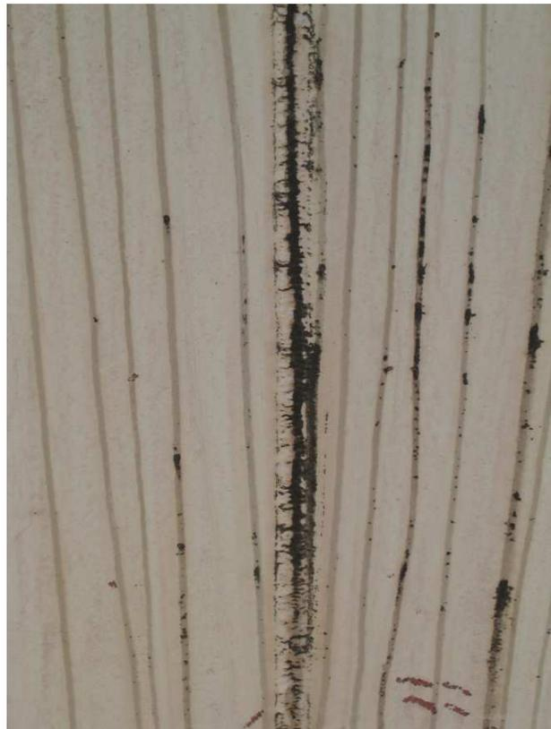
Figura 3. Cordão de solda com acúmulo de sujeira e oxidação pertencente a um tanque de armazenamento da PETROBRAS/REDUC.
