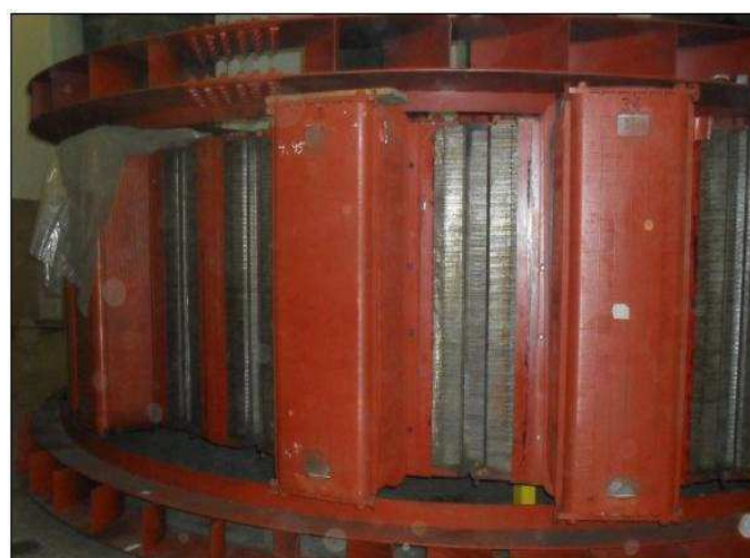
Figura 5.42: Desmontagem dos pólos do rotor.
