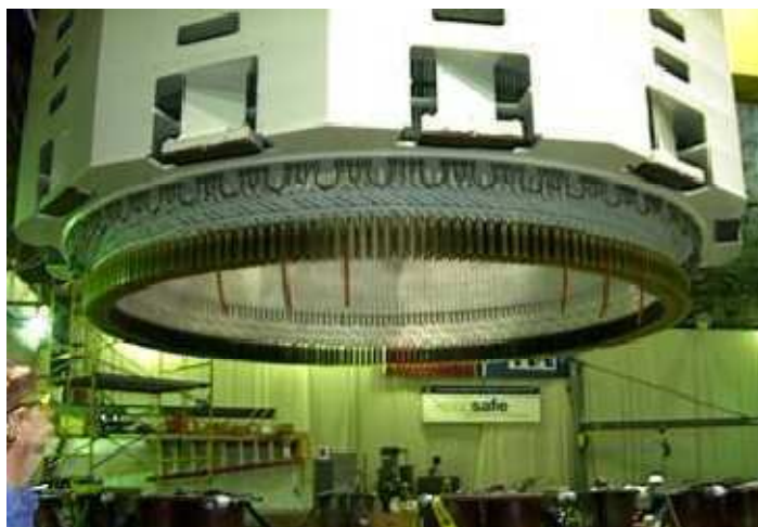
Figura 4.9: Fotografia da carcaça da Usina de Raccoon Mountain.
