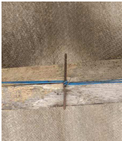
Figura A. 7: Fixação do circuito de iluminação do estacionamento.
