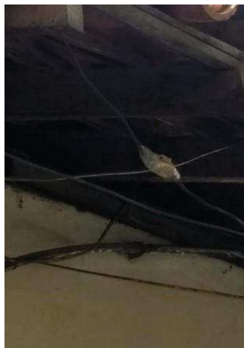
Figura A. 12: Isolação com fita crepe.
