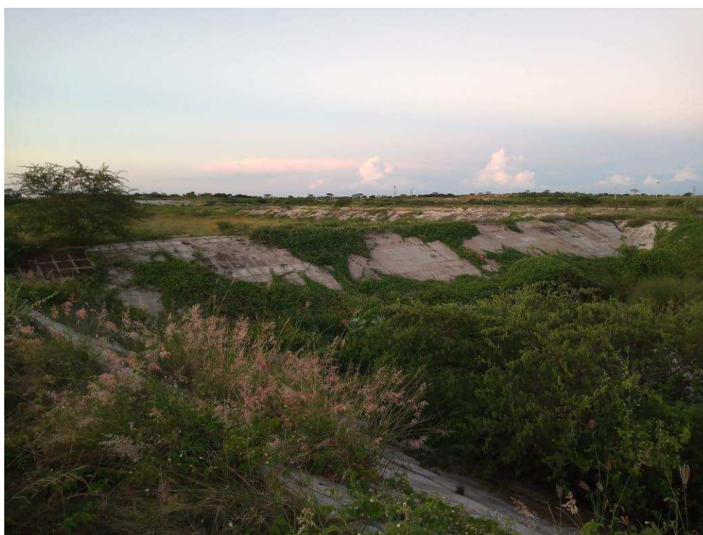
Figura 3. Situação atual da ETE do Sistema de Esgotamento Sanitário de Pombal-PB.
