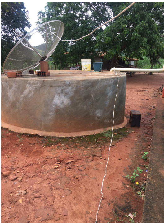
Figura 19: Registro fotográfico da cisterna 02
