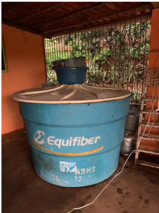
Figura 18: Registro fotográfico da cisterna 01
