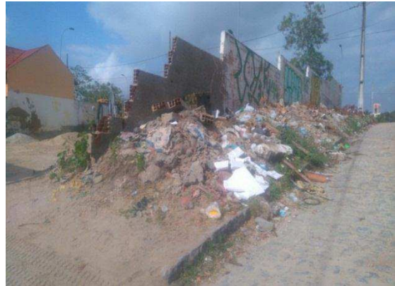
Figura 8 – Bairro Bodocongó, Campina Grande-PB.
