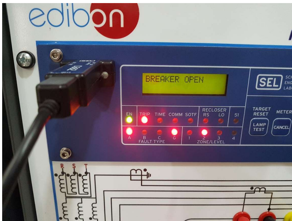
Figura 21: Detecção de falta fase-terra.
