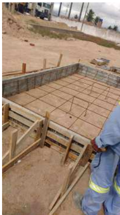
Figura 9 – Armação de uma base de Disjuntor e TC de 69 KV
