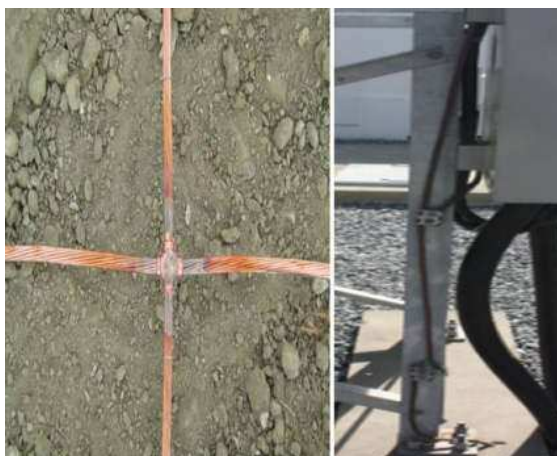
Figura 2 - Conexão da nova malha de aterramento e aterramento dos novos equipamentos
