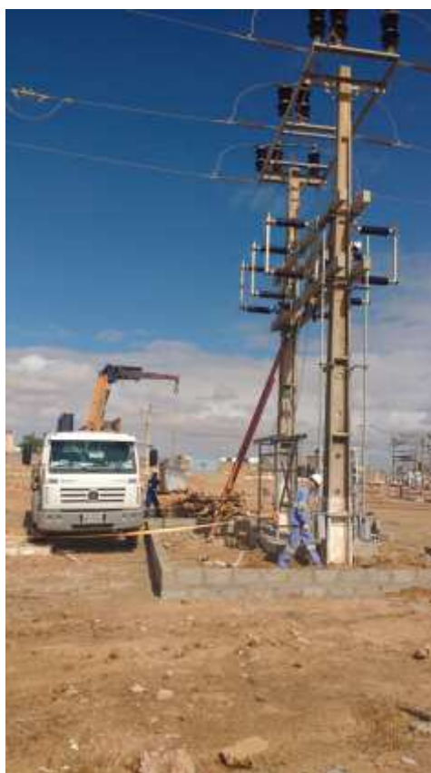
Figura 4 – Construção de um novo pátio de Britas na SE Belém do São Francisco
