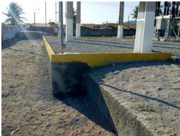
Figura 3 – Extensão do Pátio de Britas da SE Águas Belas
