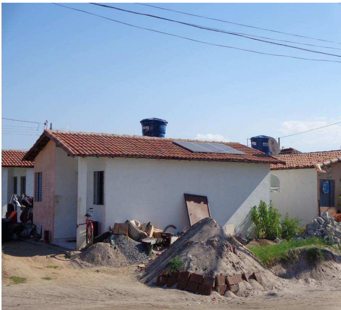
Figura 12 - Uma das residências com geração fotovoltaica
