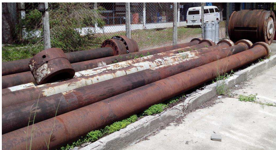
Figura 14: Inspeção visual de recipientes e tirantes na área satélite do almoxarifado
