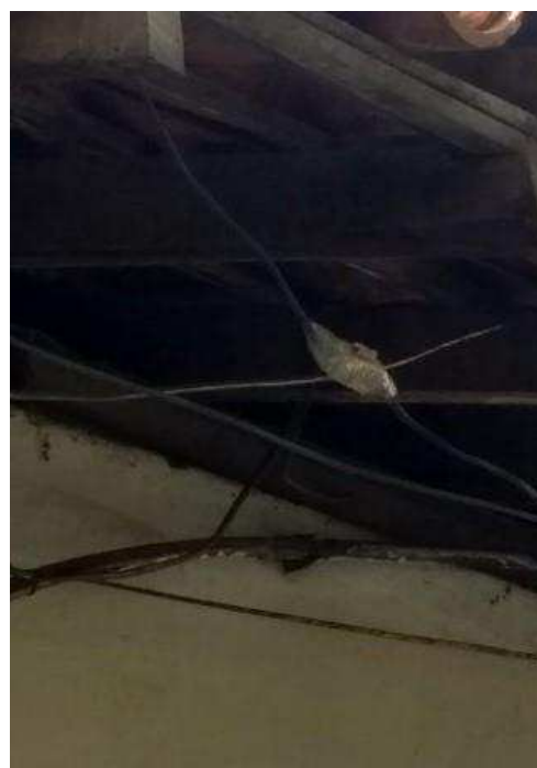
Figura A.12: Isolação com fita crepe.
