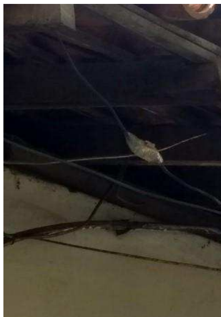
Figura 3.5: Isolação com fita crepe.
