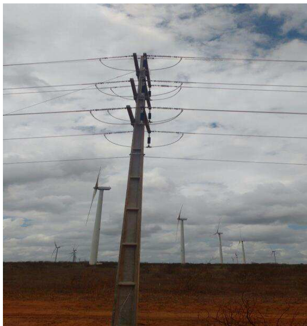
Figura 3: estrutura de ancoragem
