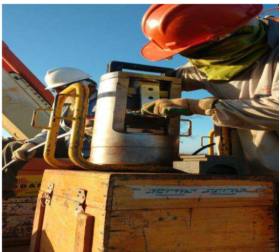
Figura 44: Cabos sendo prensados
