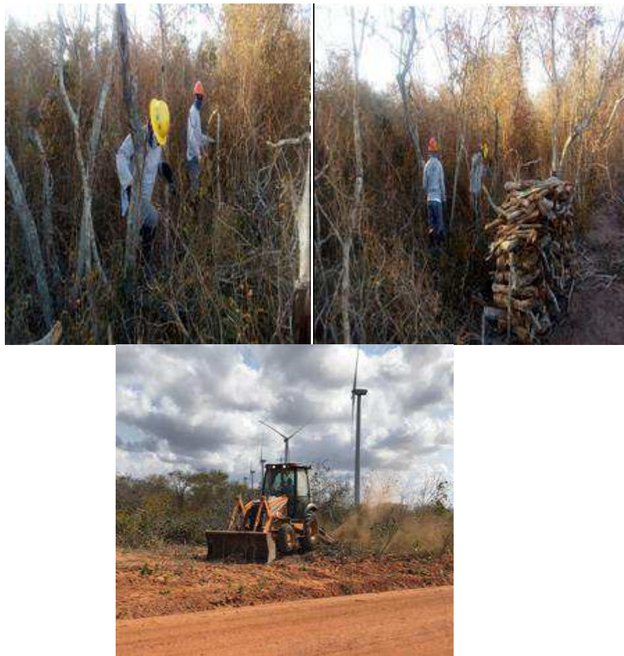
Figura 34: atividade de supressão vegetal manual e com auxílio de máquina
