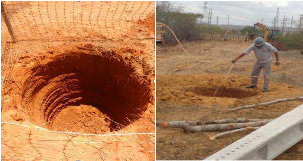
(a) Estrutura completamente escavada (b) Estrutura sendo alagada
