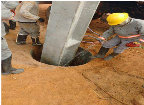
Figura 14: Fundação sendo molhada
