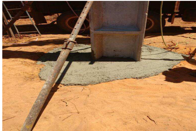
Figura 17: Concretagem completa de estrutura
