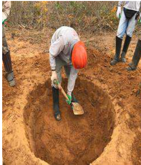
Figura 35: conclusão da escavação manual
