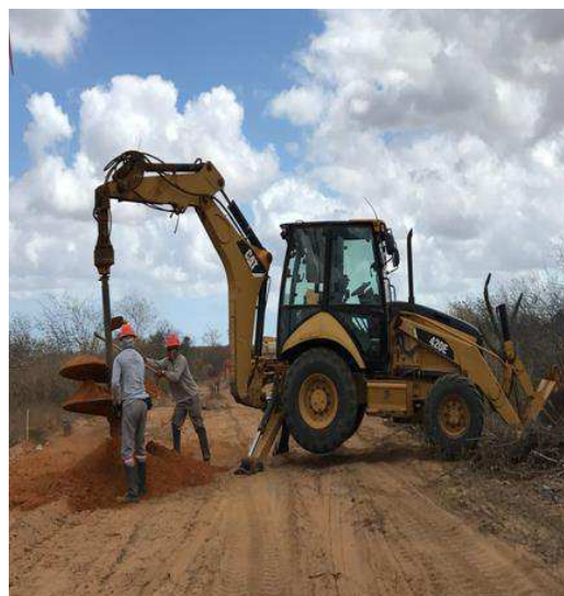
Figura 36: escavação com retroescavadeira
