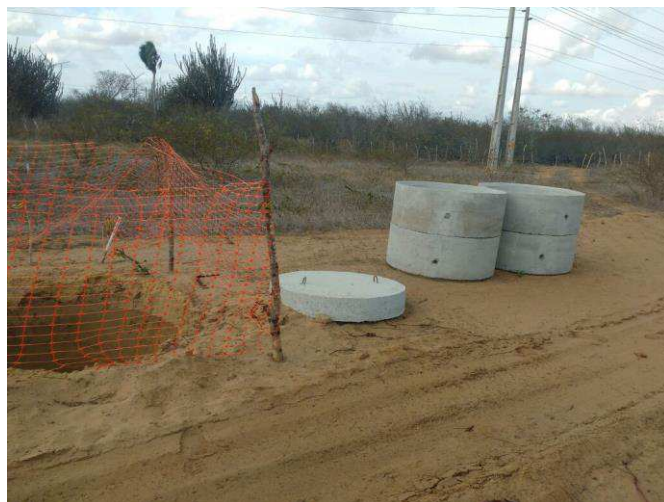
Figura 38: Manilhas e fundo de cava distribuídos
