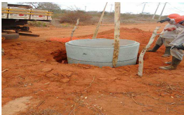
Figura 12: inserção de manilhas nas estruturas
