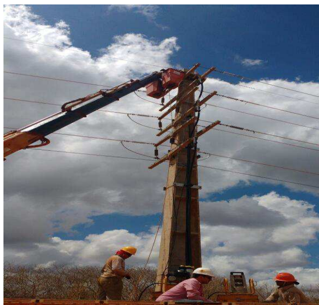
Figura 45: Instalação de Jumpers
