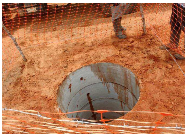
Figura 13: inserção de manilhas nas estruturas (2)
