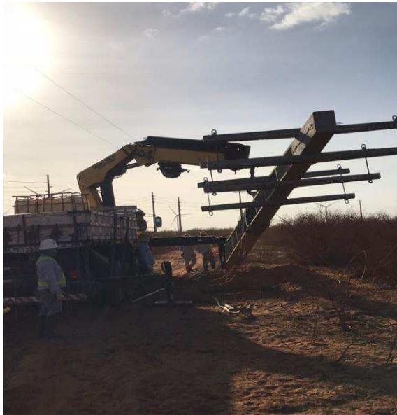
Figura 42 (a): Implantação de poste
