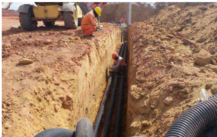
Figuras 29: Realização de travessias subterrâneas
