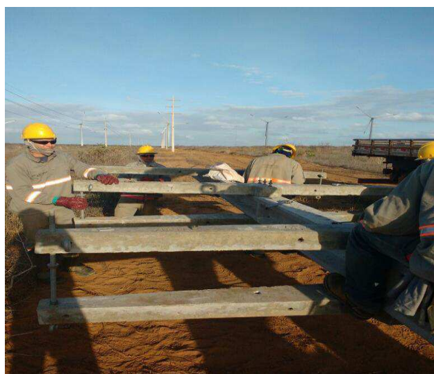
Figura 41: Estruturação de postes
