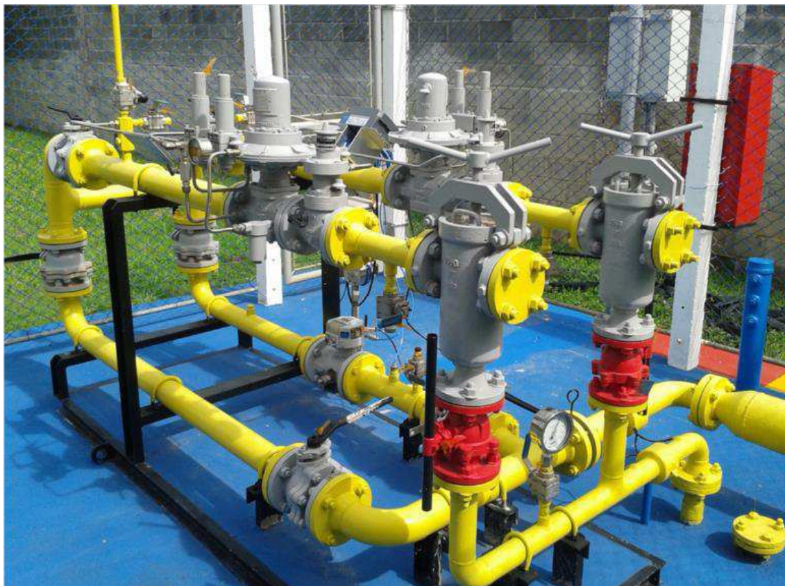
Figura 8– ERPM semelhante à existente na Acumuladores Moura.
