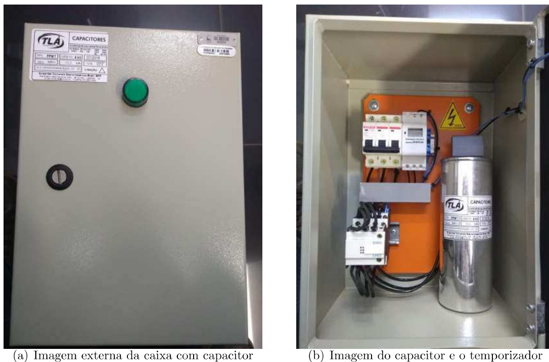
Figura 19: Capacitor de 10 KVar a ser instalado
