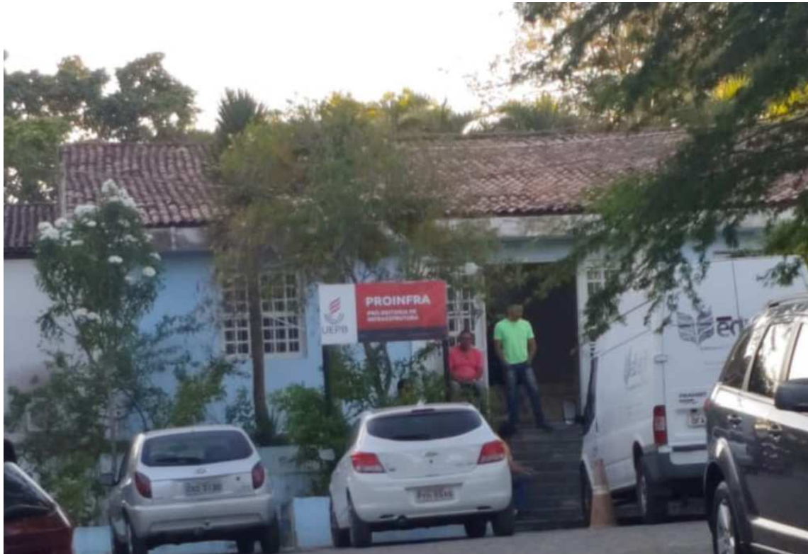
Figura 2: Prédio da PROINFRA. Autoria própria.
