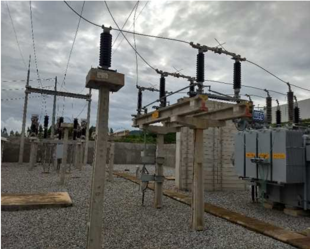
Figura 18 – Chegada do Transformador 1x10/12,5 MVA na SE69 kV Serra.
