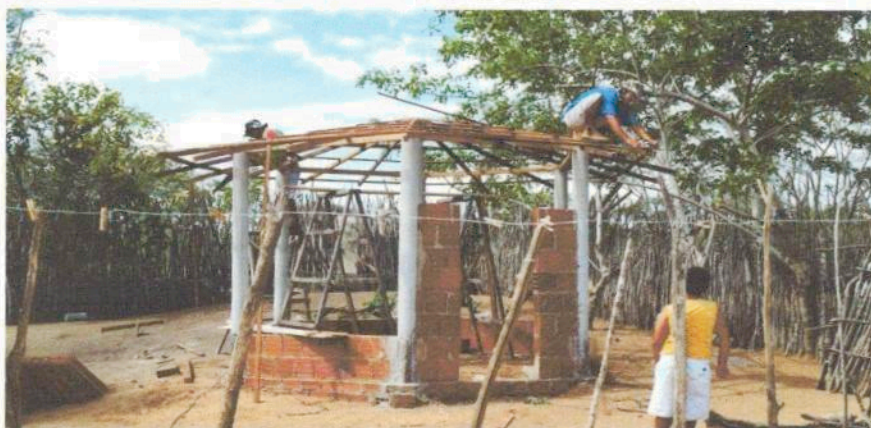
Figura 04: Fase de construção dos galinheiros no Assentamento
