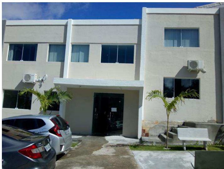
Figura 1 – Fachada do Laboratório de Alta Tensão.
