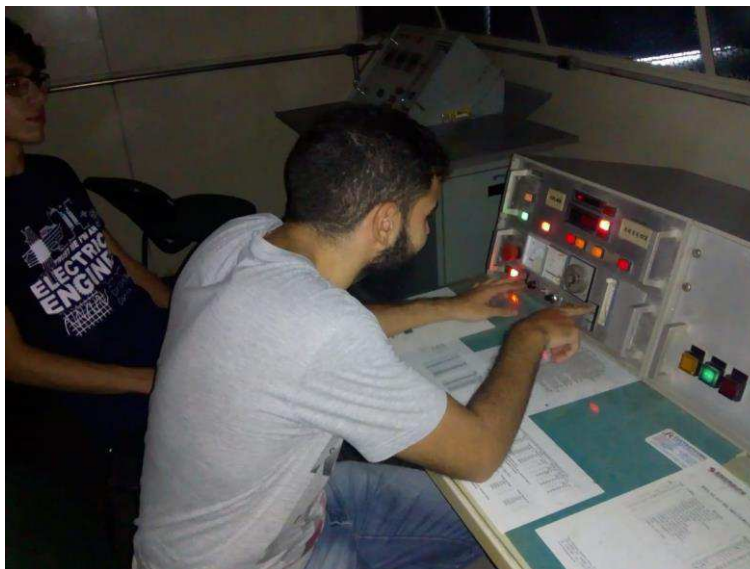
Figura 8 – Estagiário no painel de controle do Salão de Alta Tensão.
