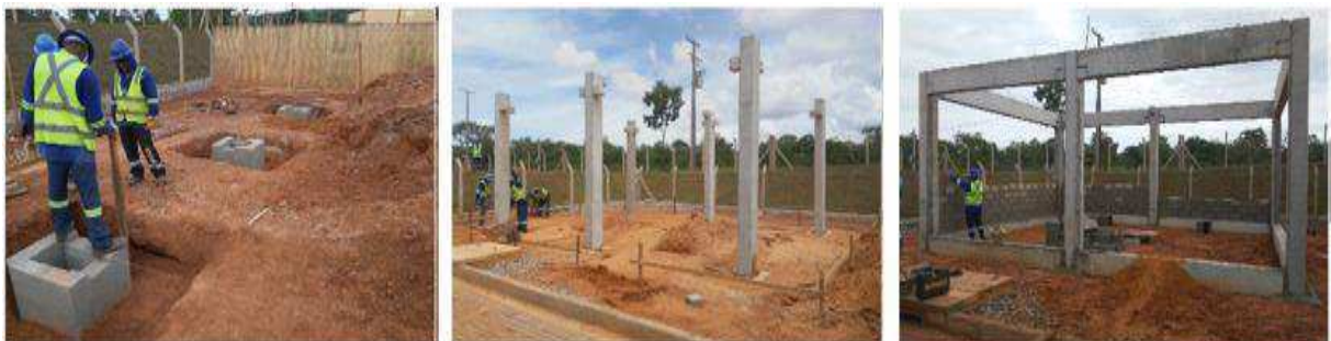
Figura 24: Construção casa de comando
