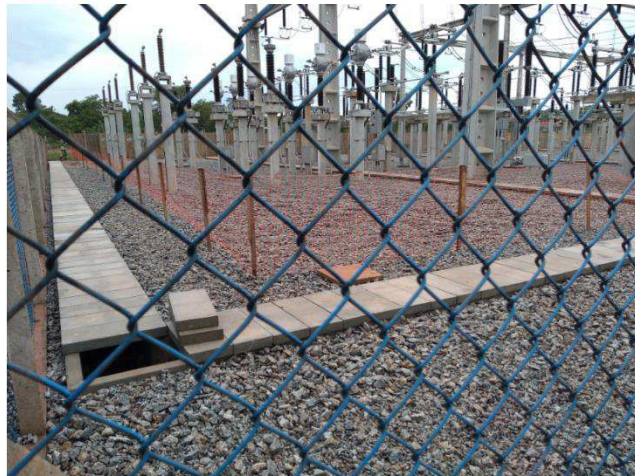
Figura 27: Parte da Canaleta
