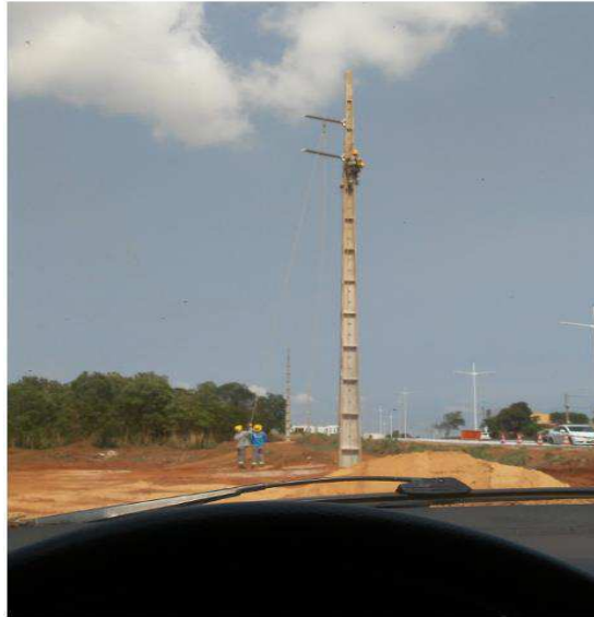
Figura 10: Montador fixando isoladores
