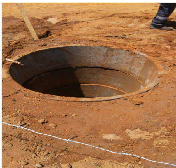
Figura 6: Manilhas instaladas nas escavações
