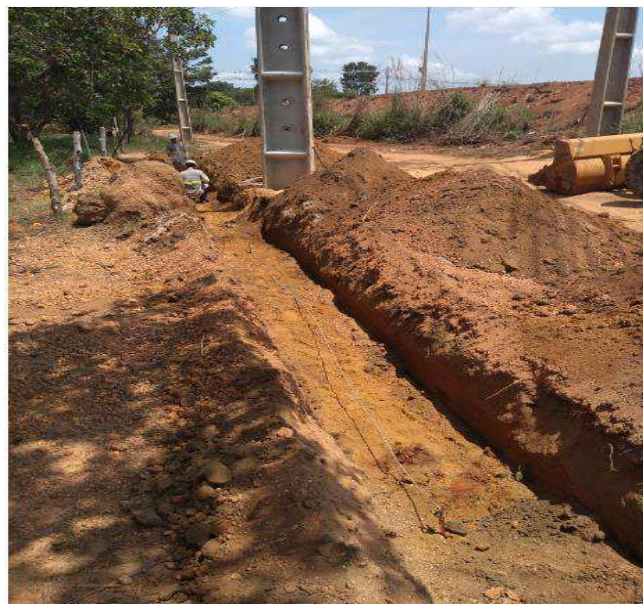
Figura 11: Aterramento de um poste
