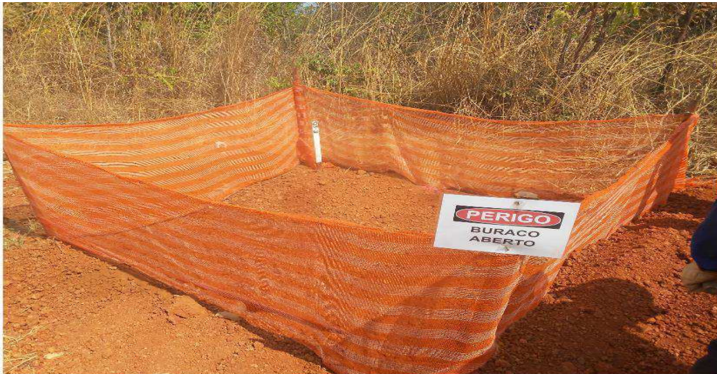
Figura 5: Escavações para implantar os postes da LDAT
