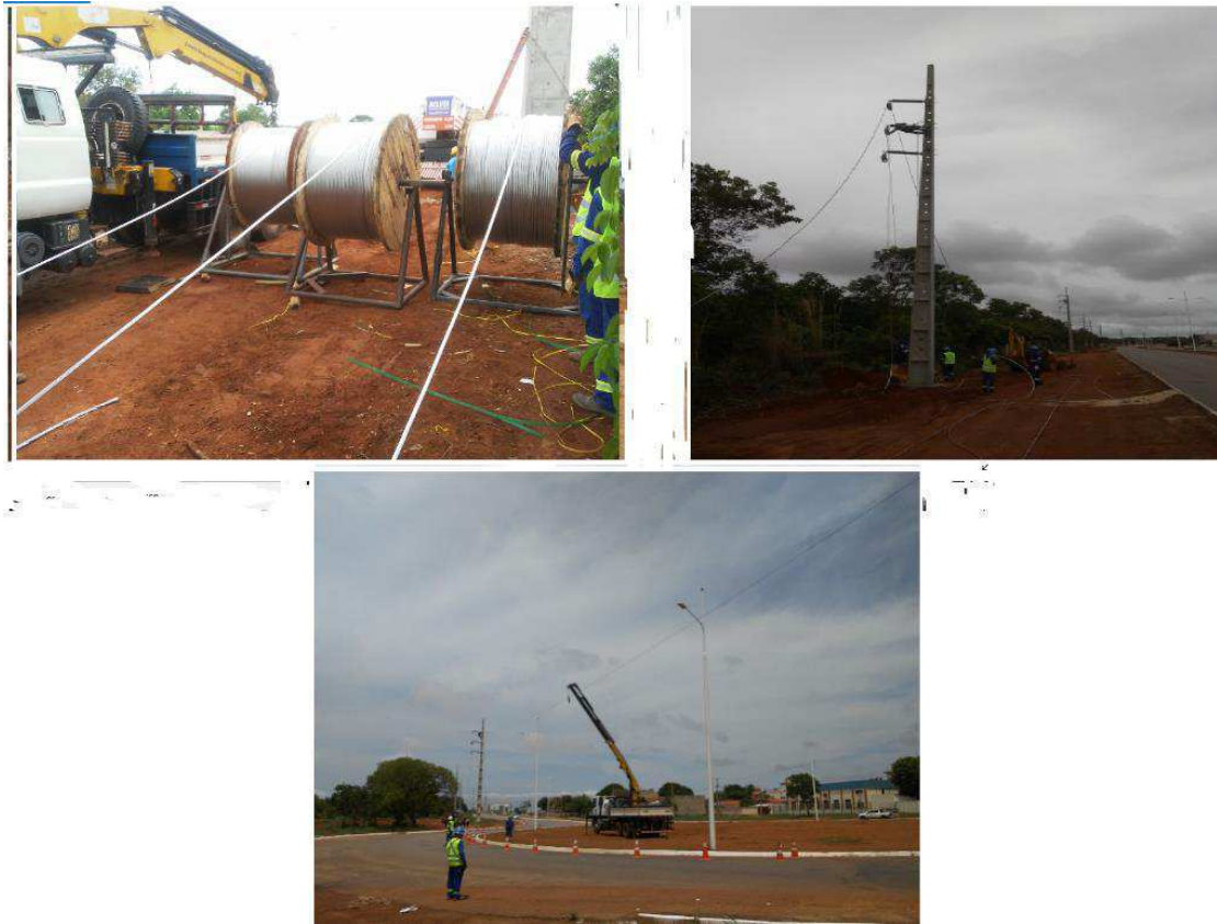
Figura 14: Lançamento de cabos
