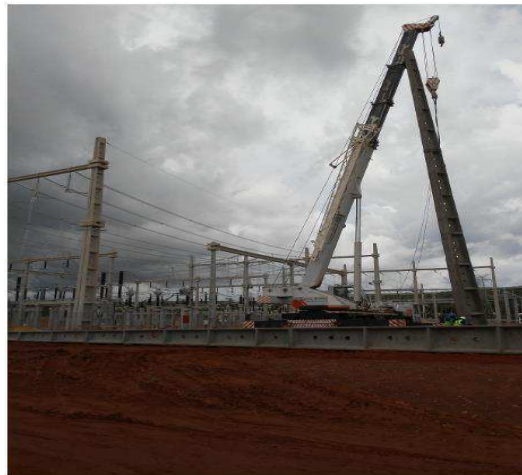
Figura 23: Implantação de poste na SE
