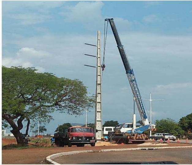
Figura 8: Implantação de poste
