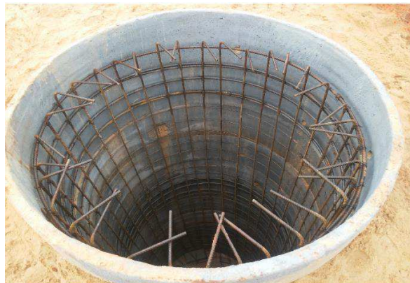
Figura 22: Base para os postes da SE
