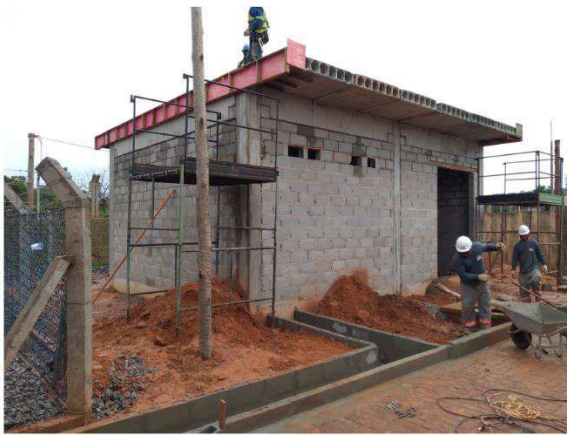
Figura 25: Casa de comando
