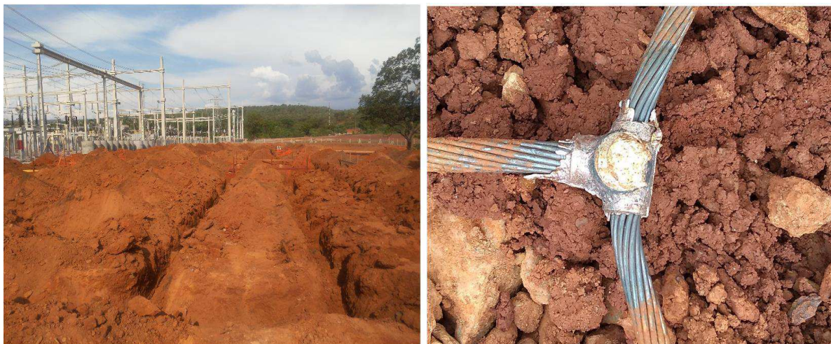
Figura 20: Malha de terra
