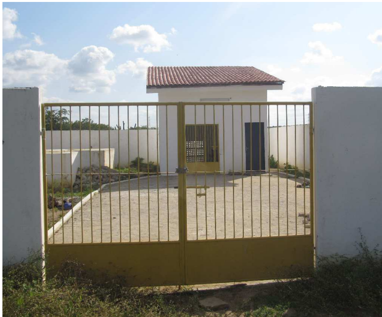
Figura 25 – Ponto de atendimento.
