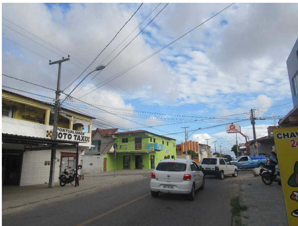
Figura 15 – Local em que será instalado o poste para derivação de rede.
