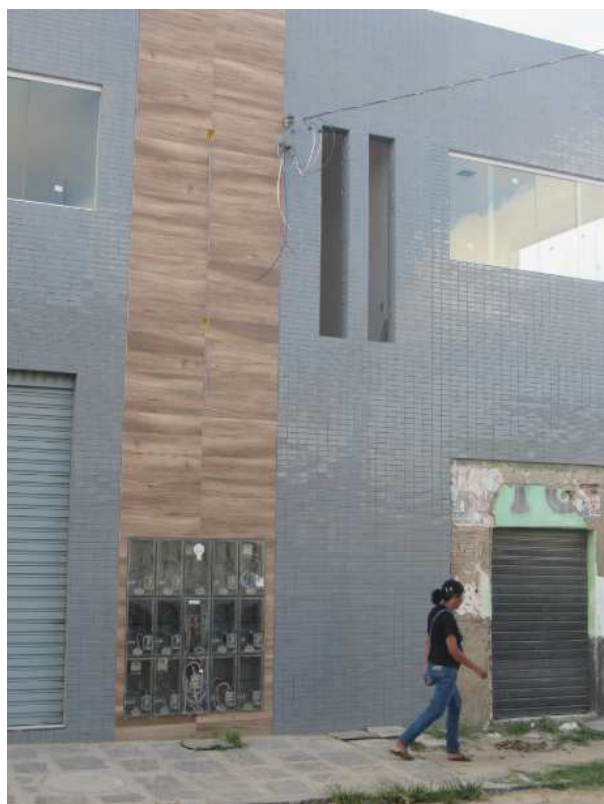
Figura 14 – Padrão pronto para instalação de transformador de 75 kVA.
